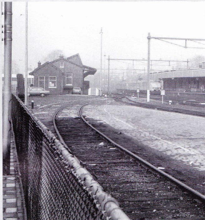
Typisch voorbeeld van een raccordement zoals er vele honderden waren in Nederland. Het in de straat verzonken spoor dat naar een loods leidt, hier van Van Gend en Loos; in de jaren zestig nog te zien op het station van Naarden Bussum. Nu parkeren reizigers hier hun auto's. (foto PaKl)
