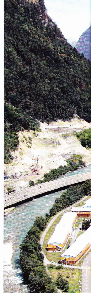
Bouwplaats Amsteg. (foto Gotthard AlpTransit)
