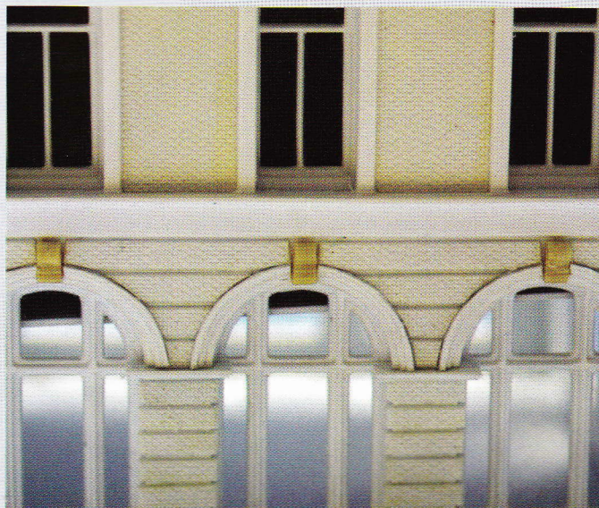
Sommige onderdelen, zoals de ornamenten tussen de bogen, zijn uit kunstharz gegoten of met de 'verloren was-methode' gemaakt.
