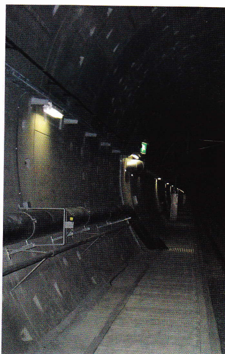
De zuiderbuis van de Zevenaartunnel. Aan het ronde profiel is te zien dat deze tunnel is geboord. De tunnelwand is bekleed met talloze gebogen betonnen platen.
