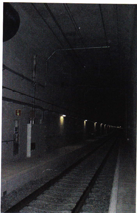
De zuidertunnelbuis van de Pankantunnel. Goed te zien is het rechthoekige profiel en het hoge plafond, ooit bedacht om met twee lagen containers te kunnen rijden.
