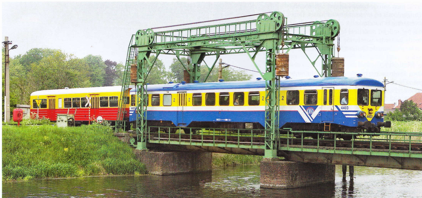
'Den ijzeren weg' komt volledig tot zijn recht op de brug over het Schipdonkkanaal in Balgerhoeke.
