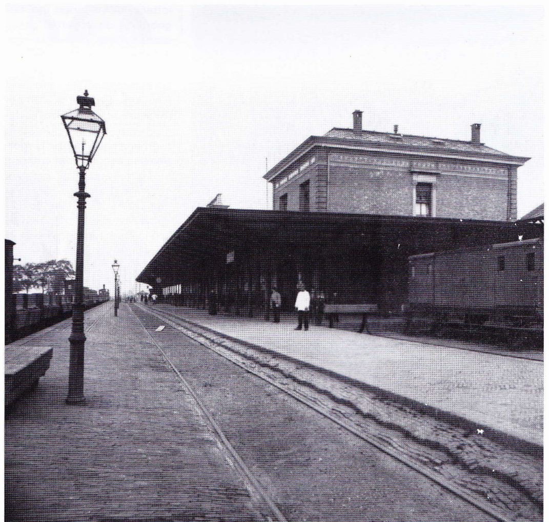
De perronzijde van het station. Door het ontbreken van goed fotomateriaal ontdekte Gerco van Beelen pas in een laat stadium dat de perronzijde niet het spiegelbeeld van de straatzijde is.
