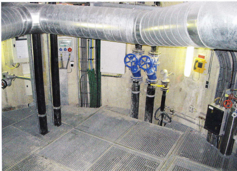
Om bij calamiteiten te kunnen vluchten zijn op diverse punten in de tunnel doorbraken naar de andere tunnelbuis gemaakt. Dit zijn geen gewone doorgangen, maar tamelijk grote ruimtes. In de ruimtes bevinden zich de nodige technische installaties. Onder het rooster op de vloer bevinden zich waterreservoirs, bestemd voor de sprinklerinstallaties.
