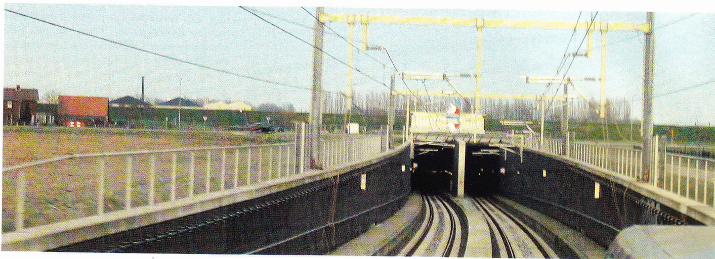
Blik vanuit loc RRF18 bij het binnenrijden van de Pankantunnel (tunnel onder het Pannerdens kanaal).
