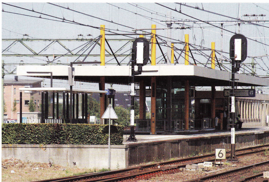
Het (voormalige) plaatskaartenkantoor herbergt nu een kiosk waar ook snacks kunnen worden gekocht. De kap wordt gedragen door tuidraden bevestigd aan zes gele pilaren, 13 juli 2006.
