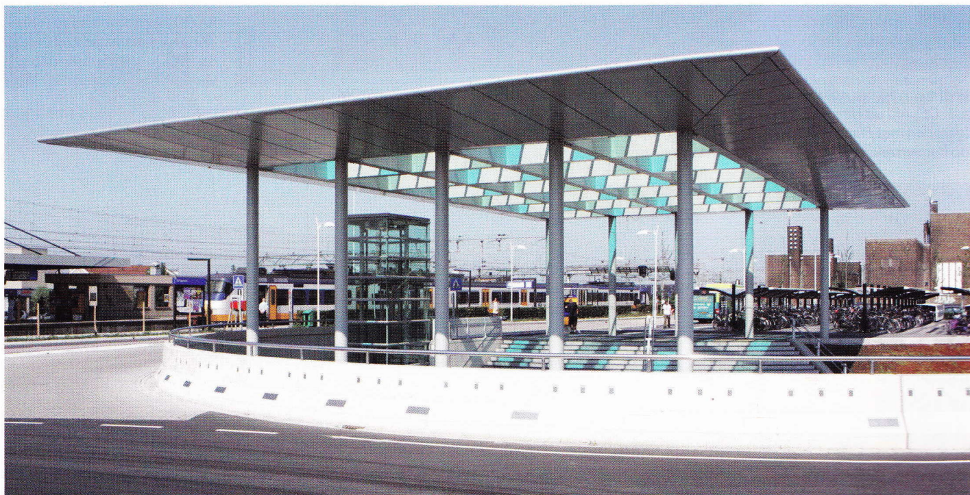
De ultramoderne kap van het nieuwe station Uitgeest is in 2006 gereed gekomen. Op spoor 1b wacht de Sprinter voor vertrek naar Utrecht CS (over Zaandam en Amsterdam Centraal), 13 juli 2006.
