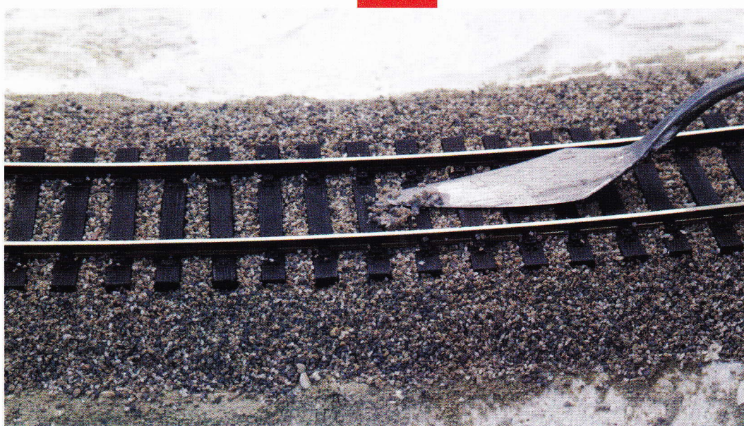
Wanneer de ballast droog is, worden de schroeven weggehaald en de gaten opgevuld.
