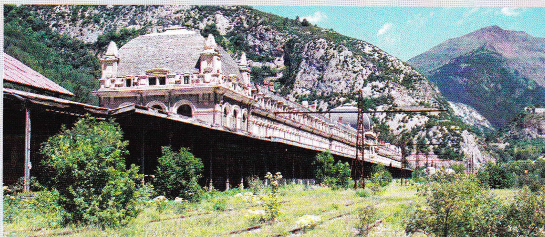
De Franse bovenleidingspalen staan te roesten en tussen de sporen gaat het onkruid zijn gang.
