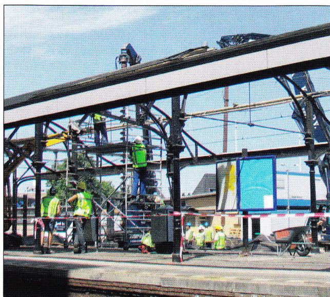
Om ruimte te maken voor de aanleg van de tunnel onder het bestaande perron, is op 15 juli 2006 een deel van de historische perronkap uit 1874 gesloopt.
