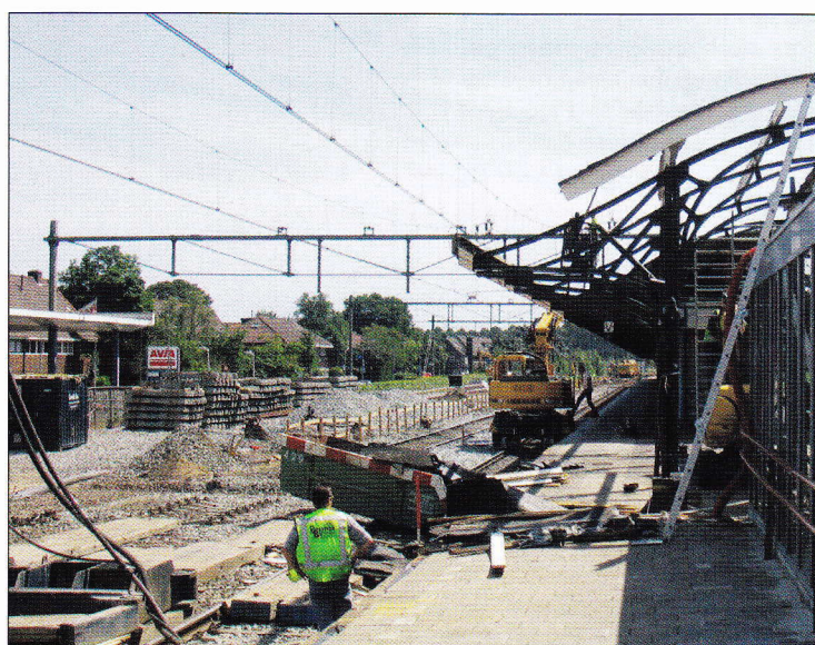
Deze foto laat duidelijk zien, waarom er beperkt treinverkeer mogelijk was. De sporen 3 en 4 zijn tijdelijk onderbroken om damwanden te kunnen slaan. Ook hier is goed te zien, dat de sporen 5 en 6 zijn opgebroken.
