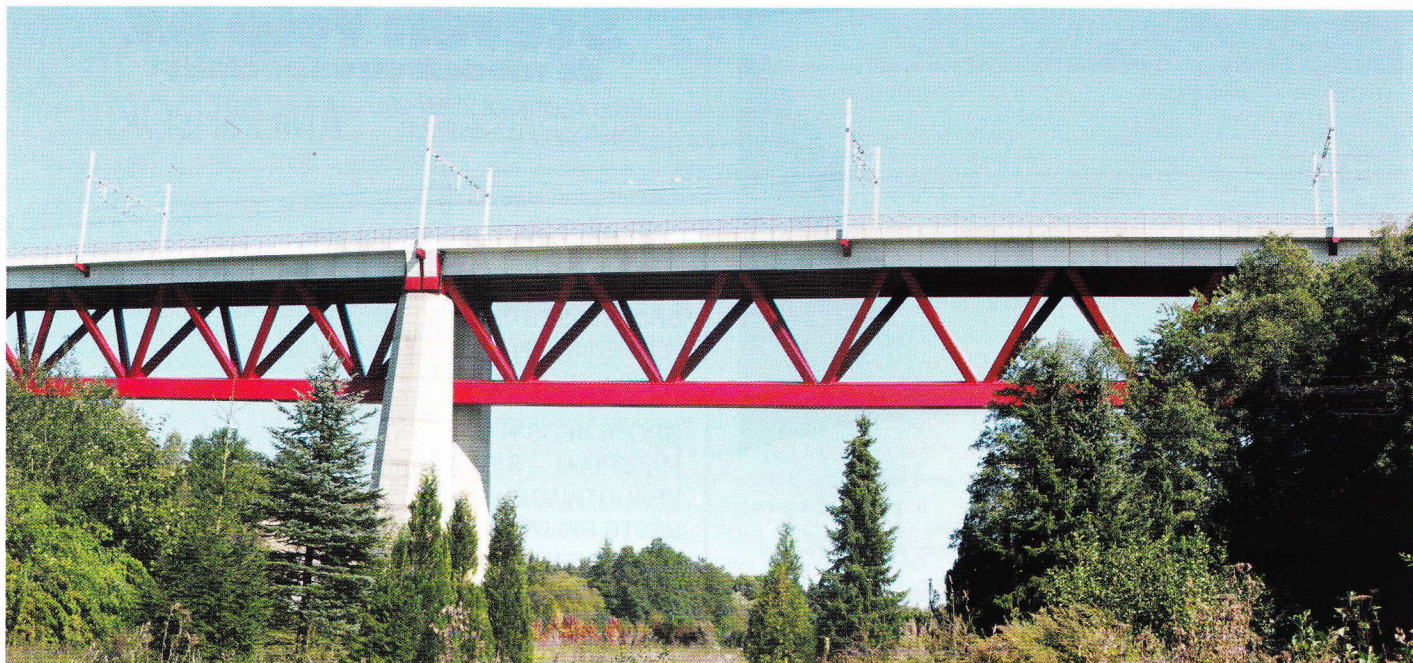
Even voor de Duitse grens bouwde de NMBS een nieuwe Hammerbrücke. 21 september 2006.
