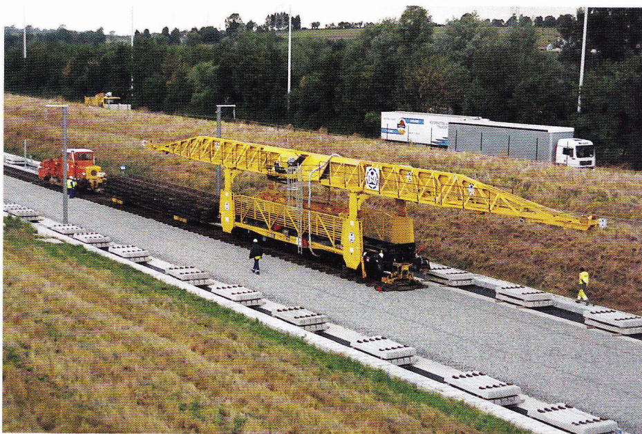
Op 1 augustus bereikten de sporenleggers bijna Welkenraedt.
