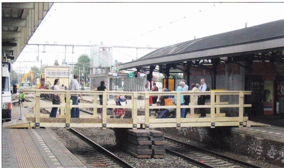
Tijdens het slaan van de damwanden onder de sporen 1 en 2 werd de treindienst afgewikkeld op spoor 3. De reizigers werden via een houten noodbrug naar dat spoor geloodst.
