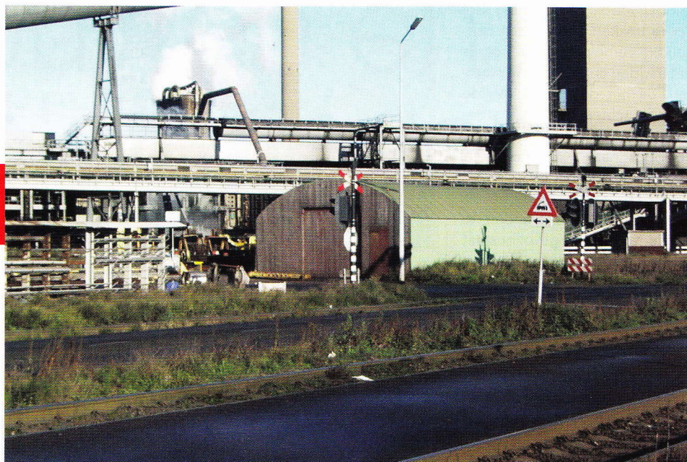
De Romneyloods die als voorbeeld gediend heeft: Corus, nabij Kooksfabriek 1.
