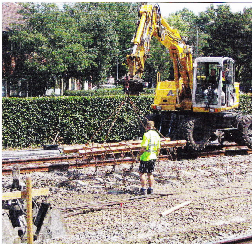
Sporen 6 en 7 worden opgebroken om ruimte te maken voor het nieuwe perron.
