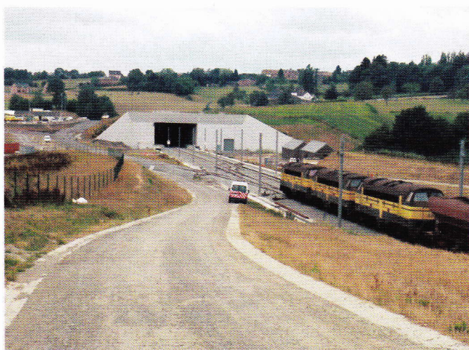
De nieuwe bijna 6 km lange Soumangetunnel is de langste op het Belgische spoorwegnet. 1 augustus 2006.
