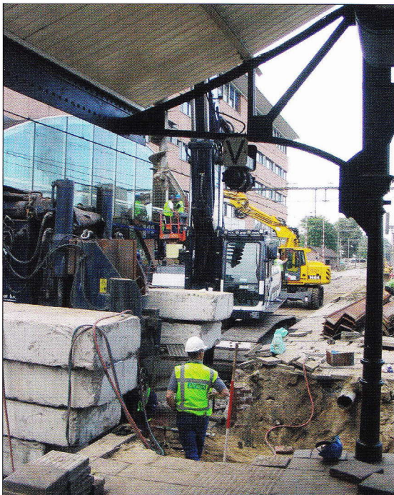
Goed is te zien, dat met grote betonnen platen als ballast de pers, de Silent Pilar, op z'n plaats wordt gehouden. In het weekend van 26 en 27 augustus jl. werden de damwanden onder de sporen 1 en 2 ingeperst.
