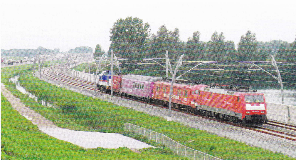
De meettrein onderweg ter hoogte van Opheusden op 1 september 2006. Links de A15 waaraan de Betuweroute parallel is aangelegd. (foto Sevrien Ferrée)
