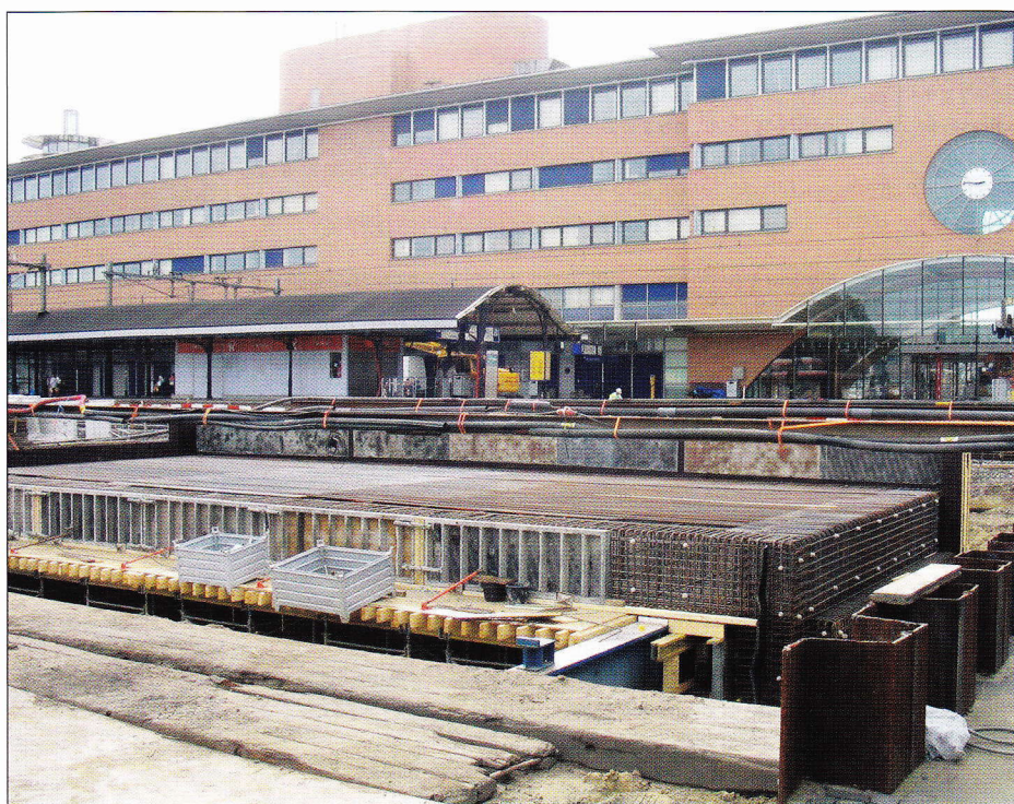
Het eerste tunneldek in aanbouw. Eind augustus 2006 is de wapening nog goed te zien. Op dit tunneldek worden straks twee sporen gelegd.
