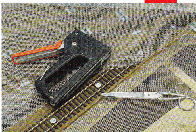
Op sommige plaatsen komt aluminium gaas beter van pas dan piepschuim. Het gaas wordt later met een laagje gips afgewerkt.
