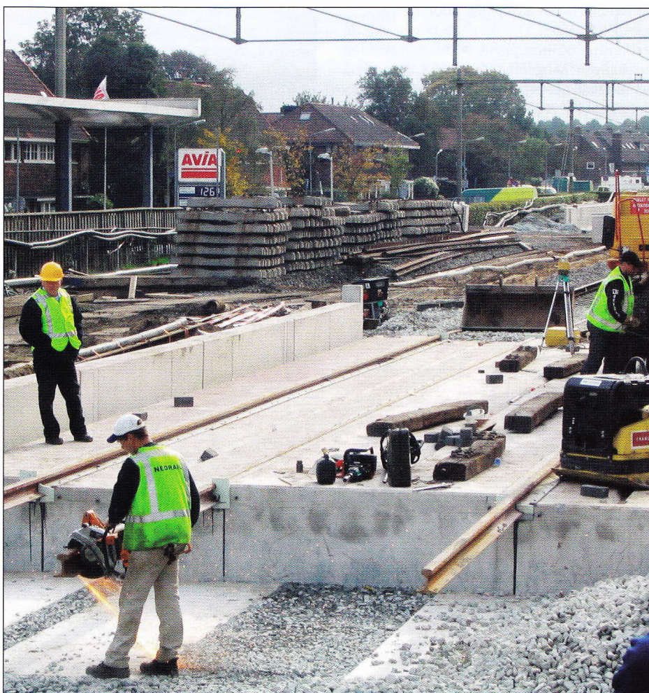
In het weekend van 21 en 22 oktober is het eerste tunneldek met de twee sporen ingeschoven. De spoorstaven zijn nog iets te lang en moeten worden ingekort. Dit tunneldek, waar de sporen 4 en 5 over worden geleid, ligt hier tijdelijk. Het dek wordt naderhand via het tijdelijk op te breken perrongedeelte doorgeschoven naar de sporen 1 en 2, waarna een tweede tunneldek op deze plek worden geplaatst.
