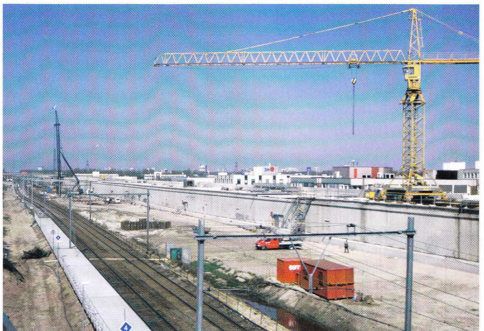
Op 8 april 2002 waren de werkzaamheden in Barendrecht nog in volle gang. De goederenspooren naar de haven zijn nog niet overdekt, de spoorlijn Dordrecht-Rotterdam bevindt zich al in de tunnelbak.
