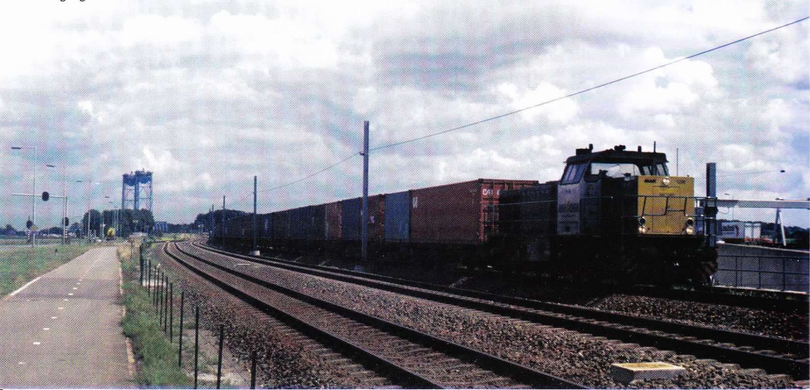
Beeld vanuit een van de portaalkranen van het Rail Service Center. De kraan overbrugt de vier doorgaande sporen, terwijl de vier kopsporen rechts te zien zijn. Op het linkerspoor is een locomotief van HGK te zien.
