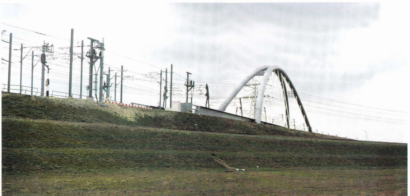
De nieuwe spoorbrug over de Dintelhaven bij Europoort.
