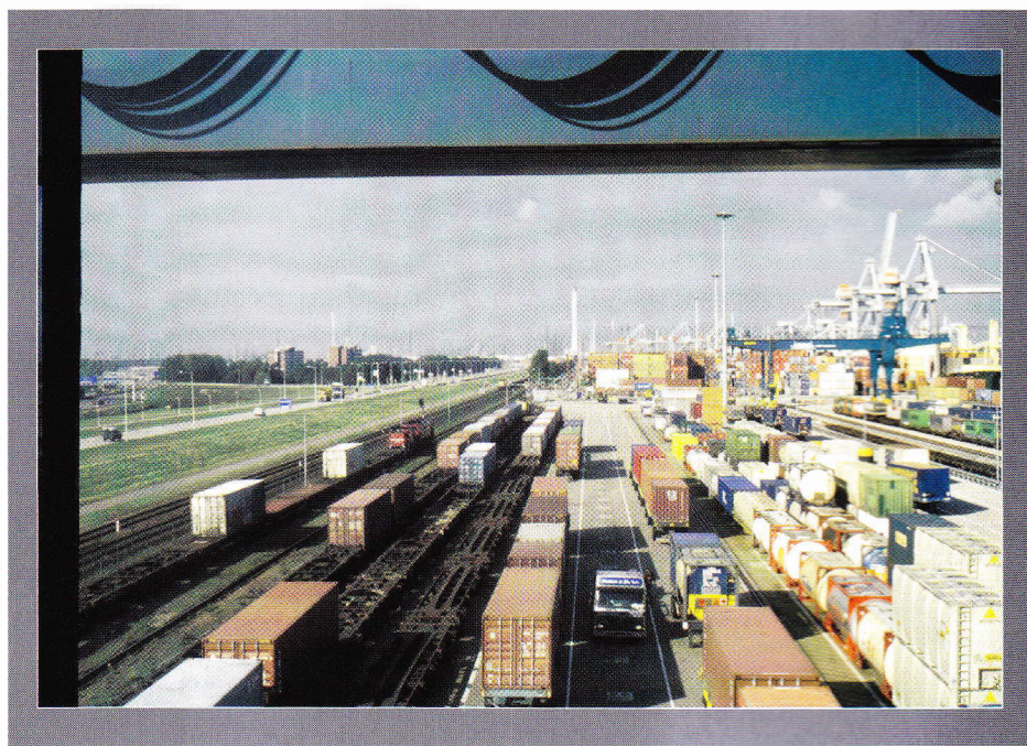
Beeld vanuit een van de portaalkranen van het Rail Service Center. De kraan overbrugt de vier doorgaande sporen, terwijl de vier kopsporen rechts te zien zijn. Op het linkerspoor is een locomotief van HGK te zien.
