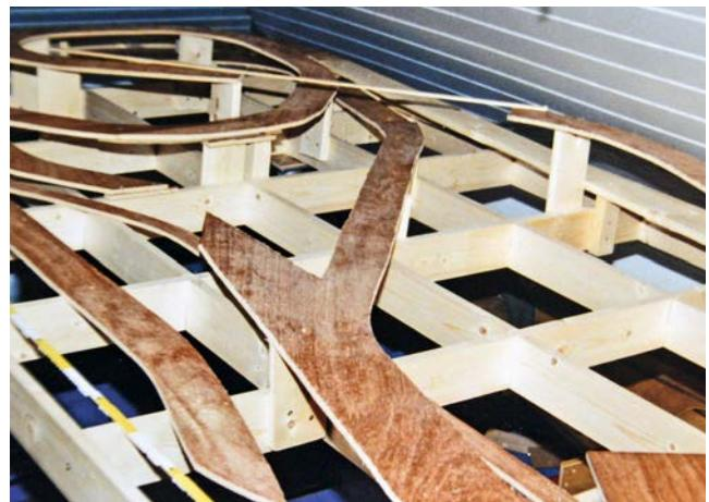
Die Trassenbrettcchen sind auf Holzleisten aufgeständert, die seitlich an den Rahmenlatten höhenjustierbar befestigt sind
