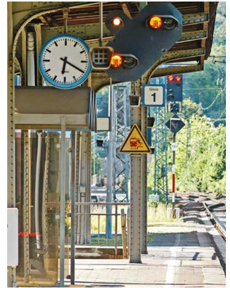
Vorsignalwiederholer für P301 unter dem Bahnsteigdach nach Abbau von Gleis 3
