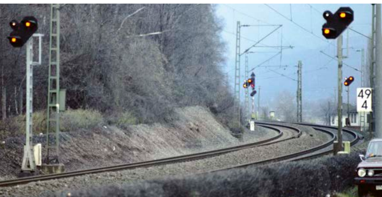
Seite Remagen verläuft die Bahnlinie in einem engen Bogen. Daher sind zwei Vorsignalwiederholer für jedes der beiden Einfahrsignale notwendig, 1980
