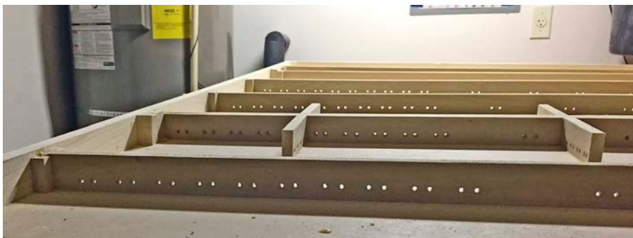
Das Anlagenbrett von der Unterseite mit den äußeren Versteifungsleisten und den Querträgern: Die vielen Löcher sind für die spätere Verkabelung nötig. Das fast drei Meter lange Brett ist verblüffend steif und dennoch relativ leicht
