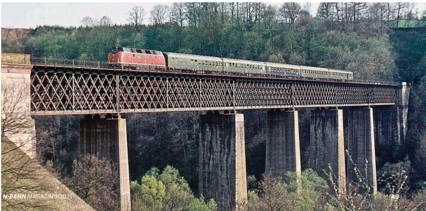
Die 220 057-4 überquert 1975 mit dem DC 954 „Frankenland“ die Kochertalbrücke mit zwei Büm 232, Aüm 202, Büm 232 und BDüms 272
