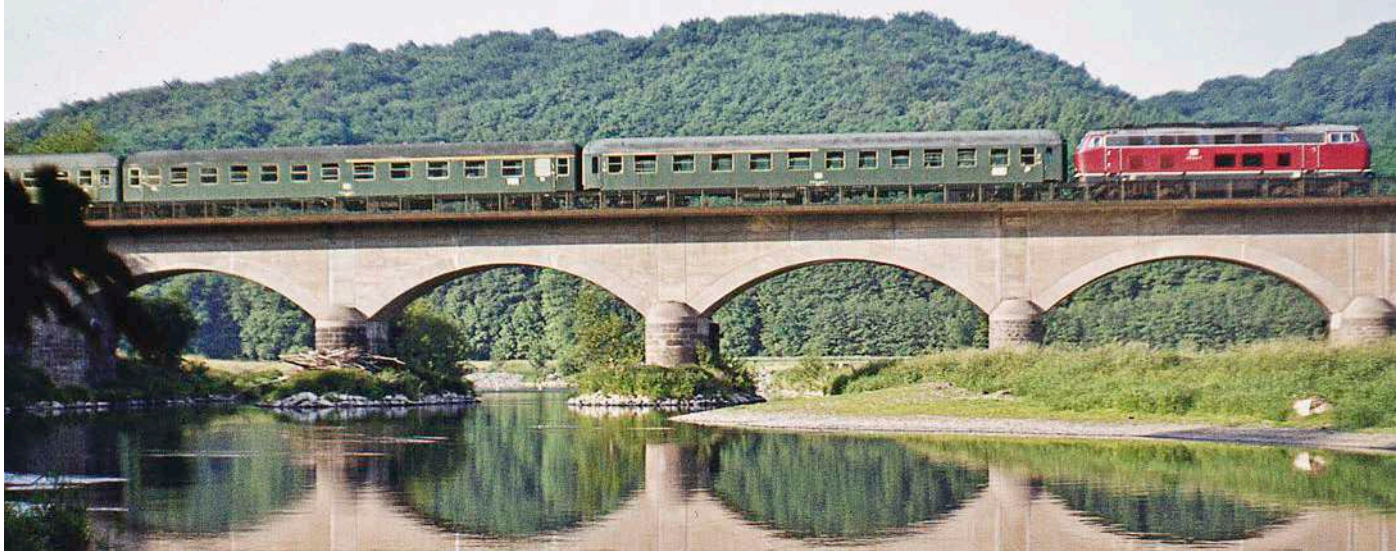
Der DC 941 „Westerland“ mit einer 215 und ABüm 225 und ABüm 223 auf der Siegbrücke bei Merten 1975
