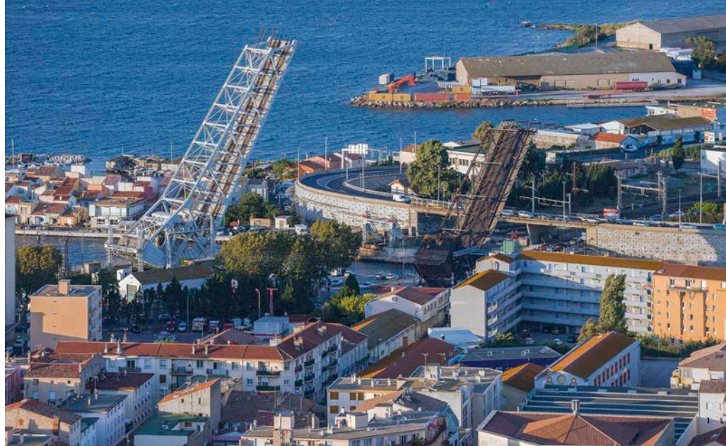
In der Ansicht aus der Luft sind die beiden Klappbrücken im geöffneten Zustand gut auszumachen. Beide überbrücken die Zufahrt zum berühmten „Canal Royal“ der Hafenstadt. Foto: Wikipedia/Christian Ferrer
