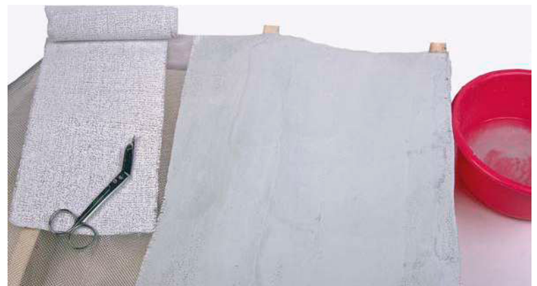
Nach dem Aufnageln werden zum Beispiel Gipsbinden zugeschnitten, getränkt und bei Bedarf auch in mehreren Schichten aufgelegt. Wichtig ist, dass man sie gut andrückt, damit keine zu aufragenden Nähte entstehen. Grundsätzlich kann man auch Spachtelmasse bei feinen Gittern auftragen, es ist aber eine gewisse Schichtdicke für ihre Druckstabilität notwendig
