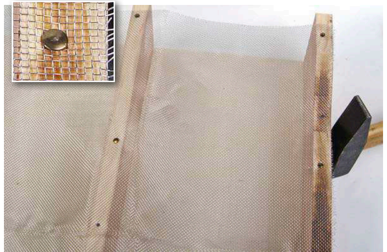
Das Aluminium-Gitter wird auf die Spanten genagelt oder geklammert. Die Nägel müssen einen hinreichend breiten Kopf haben, damit sie das Gitter verlässlich abdecken und halten, siehe kleines Bild oben
