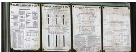
Original-Trafoschild (links) mit Schaltung, Leistungsdaten, Abmessungen und Ladeplan sowie rechts entzerrt die stilisierte Form für die Modellbeschilderung
