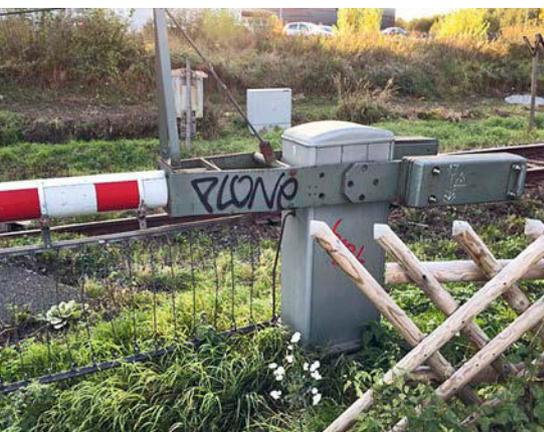
Das Vorbild ist diese etwas ältere elektrische Schrankentriebssäule
