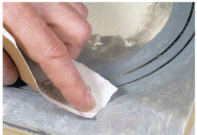
Mit feinem Schleifpapier wird die überspachtelte Straßenfläche weiterbearbeitet
