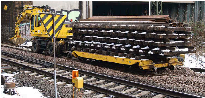
Abtransport von alten Gleisjochen auf einem Spezialflachwagen
