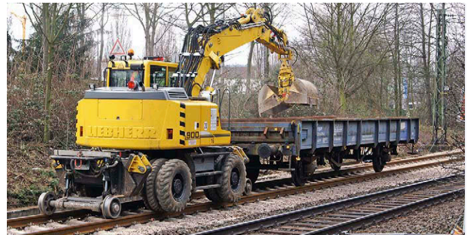
Ein Liebherr 900 entlädt Restmetallteile in Niederbordwagen
