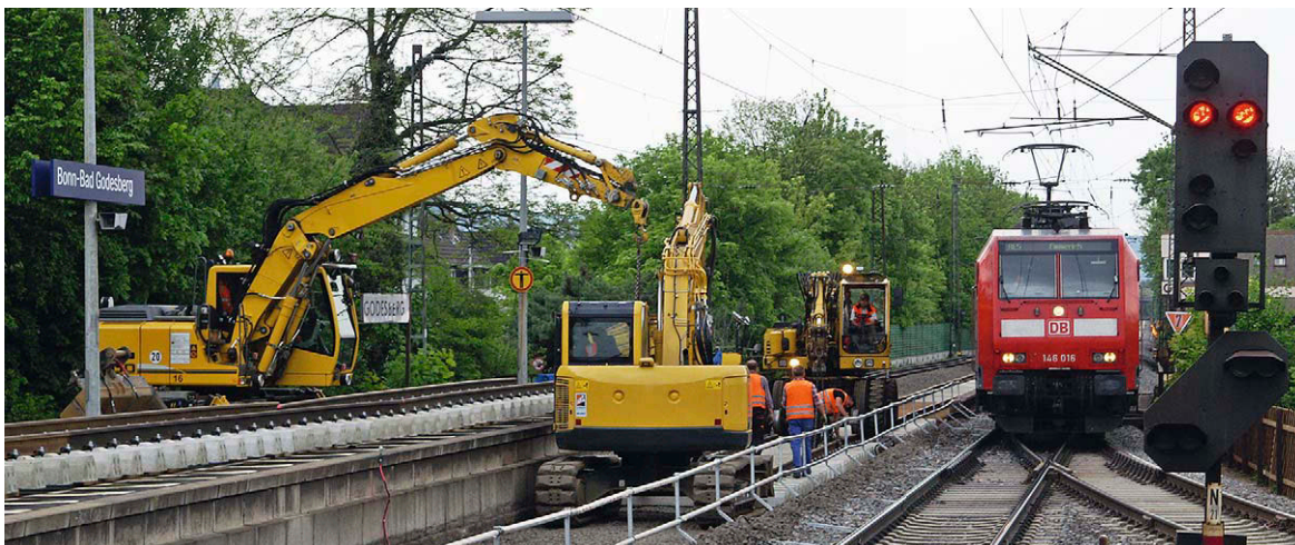
Abtransport von alten Gleisjochen auf einem Spezialflachwagen
