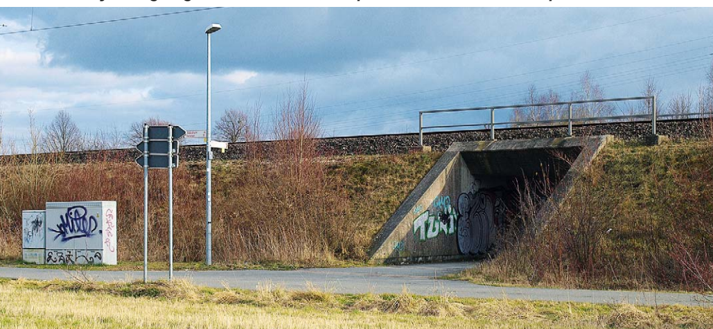
Die „Vorderseite“ der Unterführung mit davor verlaufendem Radweg. Die Straßenlampe hat eine durchaus beachtliche Höhe. Man sieht, dass die Modellproportionen von Bahndamm, Unterführung, Vegetation, Schildern, Lampen und Zäunen zusammenpassen müssen
