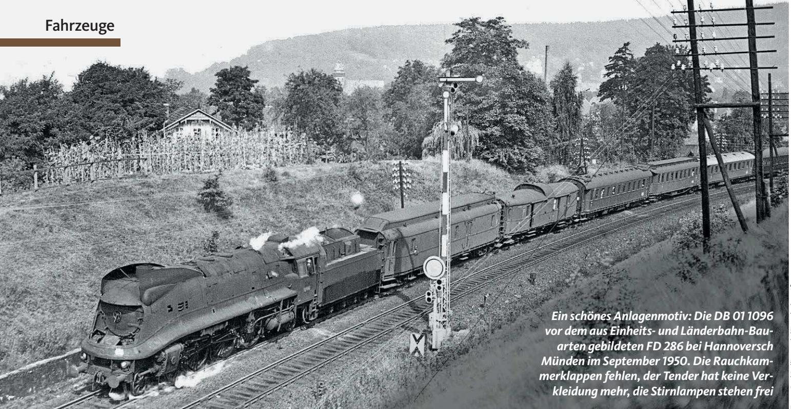
*Ein schönes Anlagenmotiv: Die DB 01 1096 vor dem aus Einheits- und Länderbahn-Bauarten gebildeten FD 286 bei Hannoversch Münden im September 1950. Die Rauchkammerklappen fehlen, der Tender hat keine Verkleidung mehr, die Stirnlampen stehen frei*
