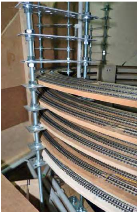
Die dreigleisige Wendel ist mit Gewindestangen aufgebaut, an denen Lochplatten als Trassen-träger mit Muttern und Unterlegscheiben befestigt sind
