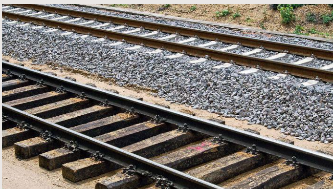
Wie mächtig das Schotterbett beim Vorbild ist, zeigt diese Situation bei einer Streckenerneuerung. Im Hintergrund ist bereits das neue Gleis mit Betonschwellen vorhanden. Im Vordergrund liegt das alte Gleisrost mit Holzschwellen direkt auf dem Planum, nachdem der Altschotter darunter maschinell entfernt worden ist
