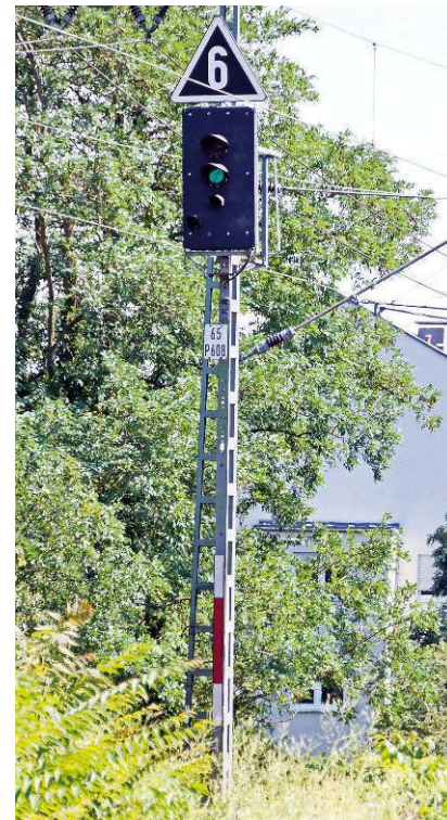
Das einfache Ausfahrsignal 65P608 in Frankfurt-Niederrad hat nur die Geschwindigkeit bei Ks 1 mit 60 km/h und kommt daher mit einer Zv 3-Tafel aus. Es kann auch Sh 1 anzeigen
