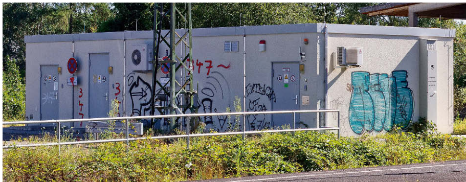
Ein typisches ESTW-Modulgebäude (hier in Eltville) mit ebenso typischem schier unvermeidlichem „Dekor“ – die Stellwerker sind nun weit weg vom Geschehen jeglicher Art
