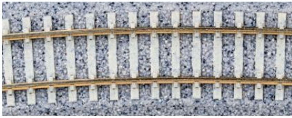
Betonschwellen bei Doppelspur
