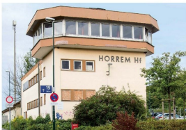
Noch immer vorhanden ist das Gebäude des ehemaligen Fahrdienstleiterstellwerks Hf. Wegen des Dreieck-Bahnhofs hat es einen rundum Panorama-Aufsatz. Dahinter steht das Ersatzgebäude des ESTW-A. Auch hier gibt es einen Wegweiser zum nach 200 Meter entfernten Gleis 19
