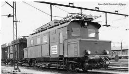
Der Fahrlösungs-Gerätswagen 767 511 (Akku-Turbinenlokomotive) der Fahrlösungsmeisterei Hirschberg steht 1934 unter einem Tragwerk für drei Gleise mit links angesetztem Ausleger
