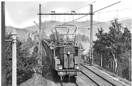
Die 1917 in Dienst genommene Stangenlokomotive ES 18 (1 te CT) mit einem Truppentransportzug aus Abteiwagen bei Waldenburg im Jahre 1919 unter einem Joch für Doppelspur mit kurzem und langem Fahrdraht-Seitenhalter. Hinter dem linken Mast erkennt man noch ein Flügelsignal
