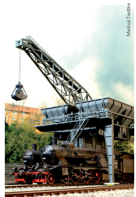
Die Kombination aus Kran und Wiegebunker bildet gerade für Schleppentenderloks eine schöne Kulisse
