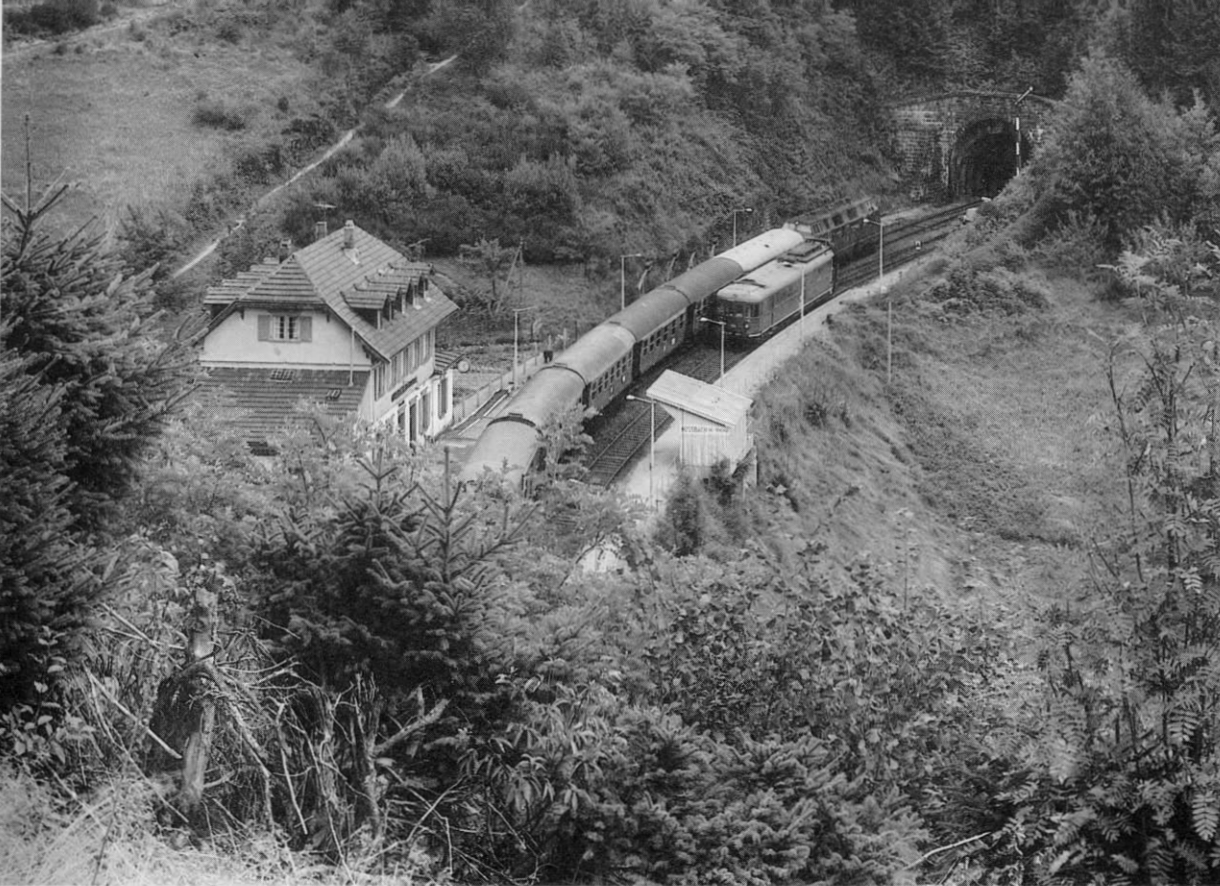
Abb. 2. Eine besondere Betriebssituation entsteht immer dann, wenn Unterhaltungsarbeiten an einem der 39 Tunnel der Schwarzwaldbahn erforderlich werden. Der Personenzug wechselt über die Weichenverbindung auf das falsche Gleis; auf dem rechten (also dem „richtigen“) Gleis steht ein Tunnelmeßwagen zur Einfahrt in den Tunnel bereit.
