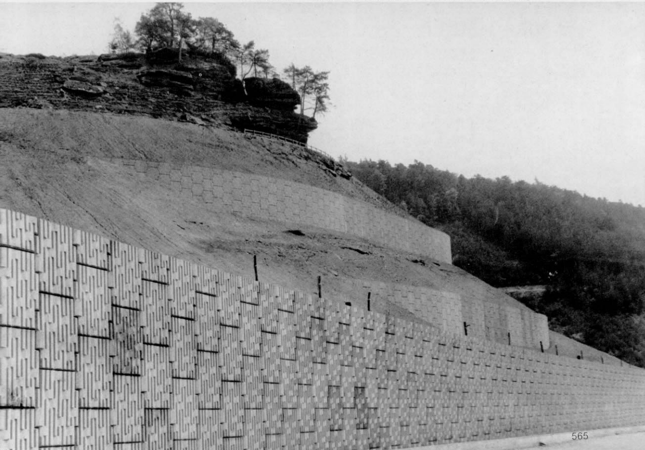
Abb. 4. Ein weiteres Beispiel für moderne Stützmauern nach dem „Bewehrte Erde“-Verfahren, bei dem einem allerdings angesichts der „unruhigen“ Strukturierung nachgerade die Augen übergehen.
