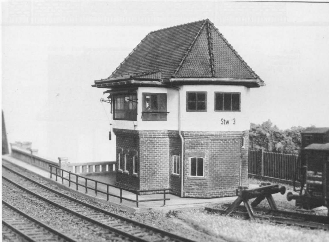
Abb. 2. Diese Modell-Ansicht entspricht ungefähr der Blickrichtung von Abb. 1. Bemerkenswert: die ungemein fein ausgeführten Seilzugvorrichtungen für die Sonnenschutz-Jalousien (s. a. Abb. 7) sowie der abgestufte Übergang der Mauersteine zum Obergeschoß.
