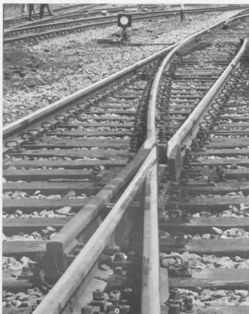
Abb. 3. Das Vorbild für die Fleischmann-Weiche: eine DB-Schnellfahrweiche mit beweglichem Herzstück (s. Heft 9/71).
