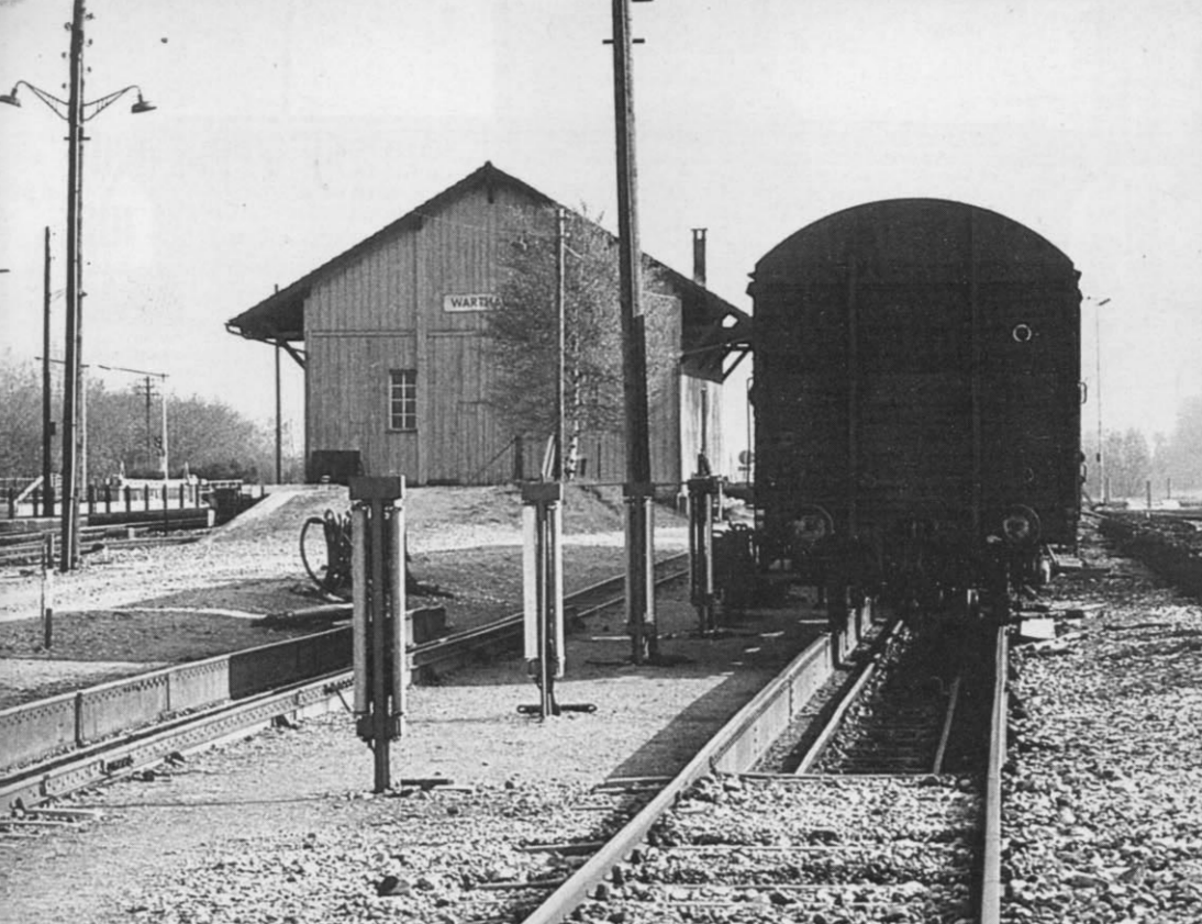
Abb. 20. Der Blick in die Rollbockgrube zeigt das zwischen den Grubenwänden verlegte Schmalspurgleis; links mehrere Halter für die Verbindungsdeichseln (s. Abb. 18), wie sie im Großen für solche Anlagen typisch sind und im Kleinen – übrigens nette und „nervenzzerfetzende“ Kleinbasteleien! – ebenfalls nachgebildet werden sollten. (Fotos Abb. 19 u. 20: Herbert Stemmler, Rottenburg)
