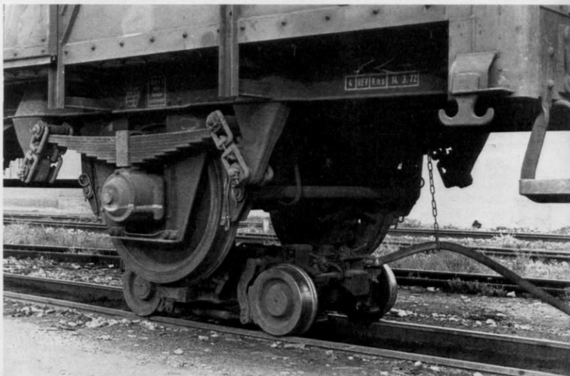
Abb. 8 zeigt, daß bei den Bemo-Rollböcken die Spurkränze der Vollspurräder wie beim großen Vorbild (Abb. 9) auf Auflegern aufliegen; die Achsgabeln verhindern ein „Täumeln“ der aufgeböckten Wagen.
