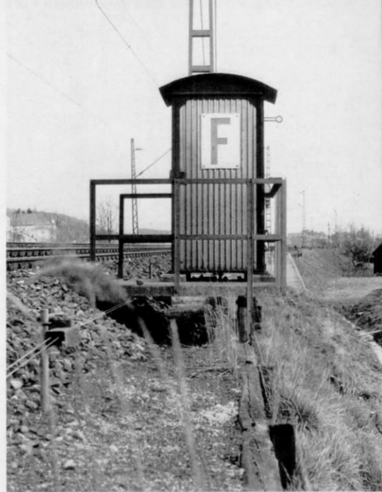
Abb. 1 (Seite 429). Das Bahndamm-Motiv mit Podesten, Drahtzügen, verbreiteter Krone, Naturstein-Stützmauer usw. (Foto Abb. 1, 2 u. 5: W. Kruse, Hamburg)
