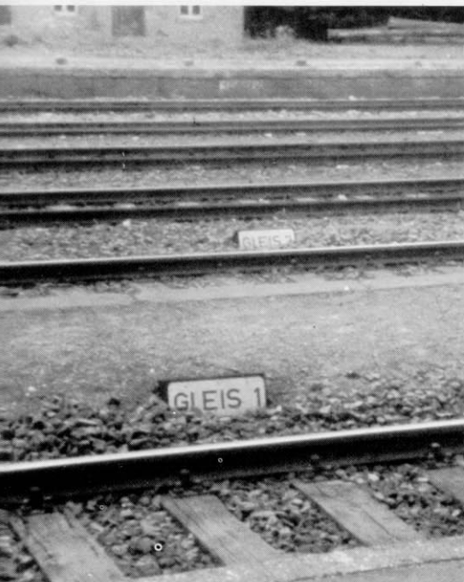
Abb. 2. . . wie diese auf Betonsockeln befestigten Gleisnummern im Bahnhof Jossa. (Foto: mm)
