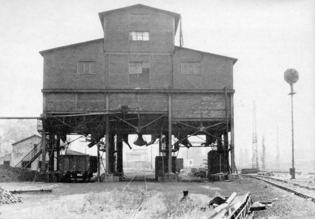
Abb. 1. Die Rückseite des Schlackenwerks. Nach links führt die Abwasserleitung heraus; im Vordergrund, rechts von der Bildmitte, eine der zwei Umlenkrollen der in der Mitte der Anlage untergebrachten Seilwinde; die zweite Rolle befindet sich etwa im gleichen Abstand auf der anderen Seite.
