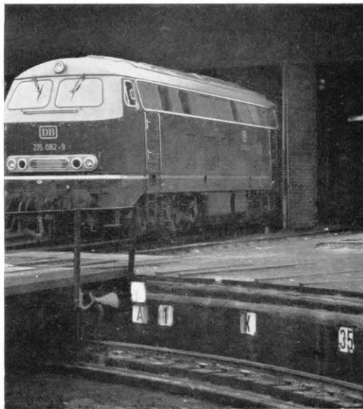
Abb. 26. Eine Drehscheibe des großen Vorbilds (Bw Heilbronn) mit den im Haupttext erwähnten Markierungen der Anschlußgleise und dem Bühnenscheinwerfer sowie der Laufschiene am Grubenrand (Blickrichtung vom Maschinenhaus).
