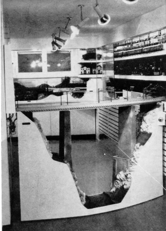
Abb. 4 u. 5 zeigen die durch den Gang des Hobbyraums führende „Drehbrücke“ in geschlossenem und geöffnetem Zustand. Die Drehbewegung der Brücke erfolgt um eine Eisenstange; der kleine Pfeil deutet auf einen Hebel, mit dem die Stange gehoben oder gesenkt werden kann. In der unteren Stellung (im Bild) ist die Stange im Fußbodenloch (Abb. 6) eingerastet; hebt man den Hebel an, wird die Brücke nicht mehr im Fußboden gehalten und kann beliebig verfahren werden.
