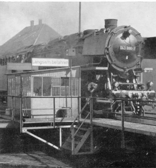
Abb. 25. Die Situation der Abb. 24 im Großen (und bei Tag): das Bedienungshäuschen mit Warnschild und Sh-Signal (hier nur von der Seite zu sehen, links neben den Windleitblechen der Lok).
