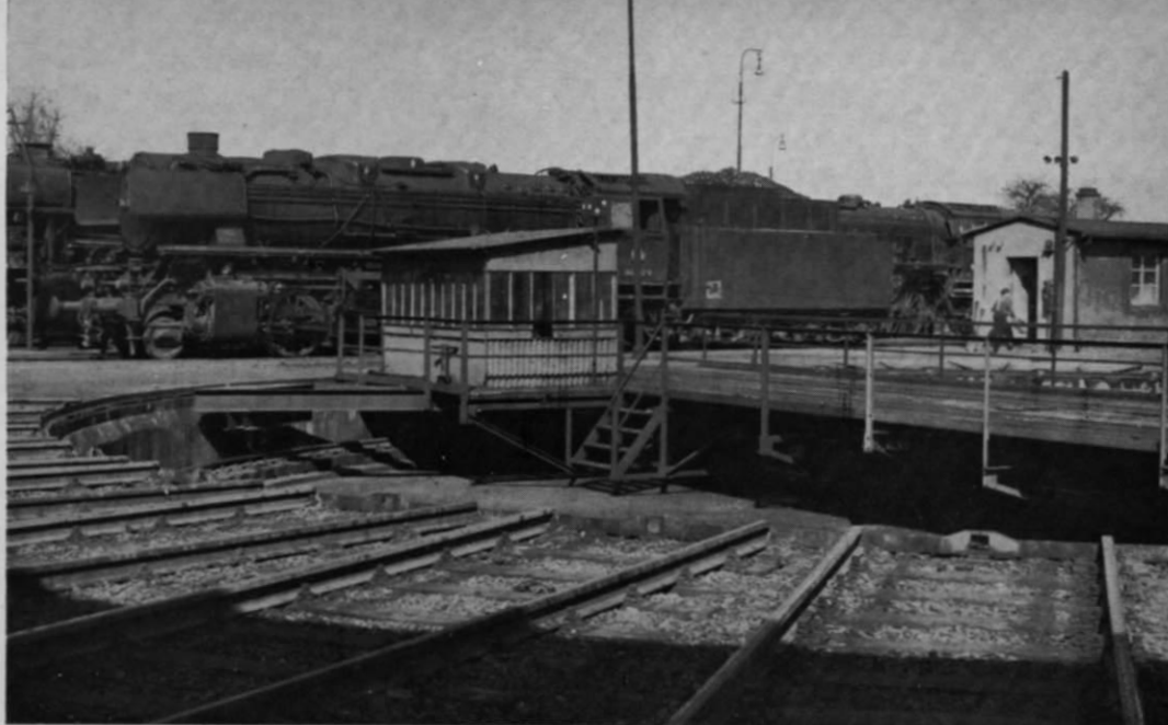
Abb. 28 u. 29 zeigen verschiedene Details von Drehbühne, Bedienungshäuschen, Niedergang zur Grube usw. im Großen (oben, Bw Crailsheim) und im Kleinen. Auch sieht man auf der oberen Abbildung deutlich die zwischen den Schienen der Anschlußgleise liegenden Verriegelungs-Profile, die beim Modell des Herrn Nawrocki auch nachgebildet wurden, freilich nur als funktionslose Attrappen (s. Abb. 6 in Heft 6/77, S. 496).
