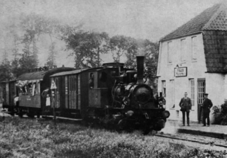
Abb. 1. Kleinbahn-Romantik „wie sie im Buche steht“: dieses historische Fotodokument stammt aus den „frühen Jahren“ der Kleinbahn Ihrhove – Westrhauderfehn und zeigt einen typischen Bimmelbahn-PmG (Personenzug mit Güterbeförderung) mit einer Bn2-Tenderlokomotive. Die Fahrzeuge dieser Kleinbahn werden wir in einer weiteren Folge dieser Serie behandeln.
