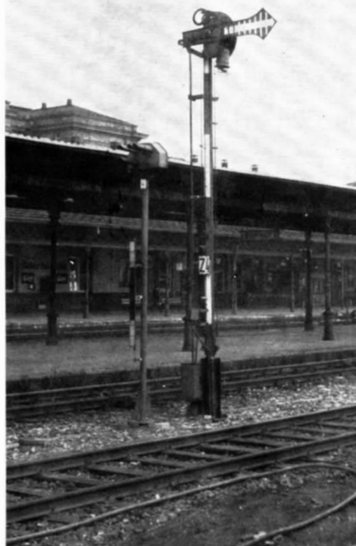
Abb. 6. Gleichfalls nach 1972 in Hof aufgenommen wurde diese Kombination von ehemaligem bayerischen Ruhe-Halt- und modernem Licht-Sperrsignal, wie man sie also auch „mit Fug und Recht“ auf Modellbahn-Anlagen darstellen kann.
