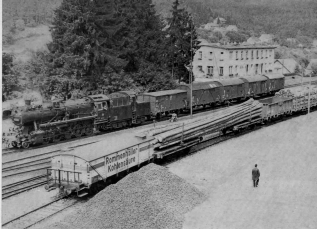
Abb. 9. u. 10. Langholztransport bei einer Vollbahn (oben, Bf. Eyach, Hohenzollern) und bei einer 760 mm-Waldbahn (Ošćadnica-Zákamenné/CSSR). Während die Drehschemelwagen nach den Vollbahn-Vorschriften mittels einer Kupplungsdeichsel miteinander verbunden werden müssen, falls sie am Anfang oder inmitten eines Zuges laufen (s. a. MIBA 3/74, S. 132), ist dies bei den winzigen Drehschemel-Loren der nur als Zubringer fungierenden Waldbahn — auf Grund der völlig anders gearteten Betriebsverhältnisse — nicht vorgeschrieben bzw. nicht notwendig.
