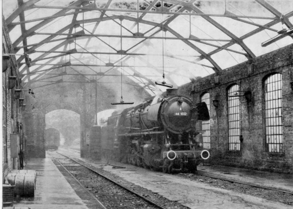
Abb. 1. Ein Rechteckschuppen mit freigelegter Dachkonstruktion im Bw Herzberg (Harz), für deren Nachbau in H0 man evtl. Teile der Faller-Bahnsteigehalle verwenden könnte.
