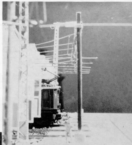
Abb. 9. Das Quertragwerk mit den daran befestigten Fahrleitungen samt Fahrdrat-Verlängerungen von der Seite gesehen. Die Schiebebühne wurde deuthlichkeitshalber herausgenommen.
