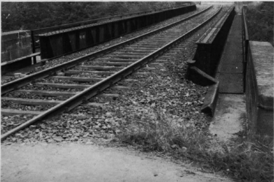
Abb. 1. Eine solche Blechträger-Eisenbahnbrücke mit durchgehendem Schotterbett ist das Vorbild für Pit-Peg's heutige Bauanleitung. Rechts am Schotterbett vor dem Blechträger der sog. „Schotterfang“.
