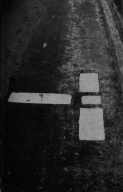
Abb. 3. Direkt auf eine Fahrbahn auf- gebrachte Markierungen in T-Form.
