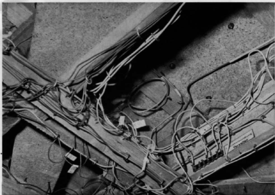
Abb. 3 u. 4. Unter der Anlage sind die diversen Kabelbäume und Einzelkabel größtenteils entlang der Rahmenleisten verlegt. Die teilweise mit Klebeband zusammengefaßten Kabelbündel verlaufen in Schraubhaken verschiedener Größen, die in den Rahmenleisten befestigt sind. Außerdem zeigen die Abbildungen diverse Verteiler bzw. Klemmleisten und deren Kennzeichnung.
