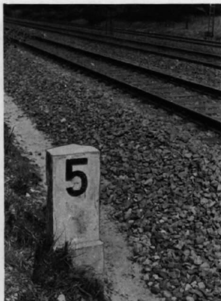
Abb. 7. Ein Kilometerstein (Abteilungszeichen) mit aufgemalter weißer Markierung. (Alle Fotos und Skizzen vom Verfasser.)
