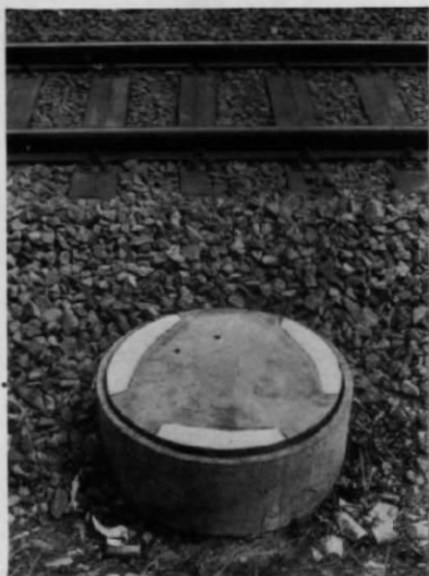
Abb. 1. Ein Kabelschacht-Deckel neben dem Bahnkörper, auf den die Markierungen direkt aufgemalt sind.
