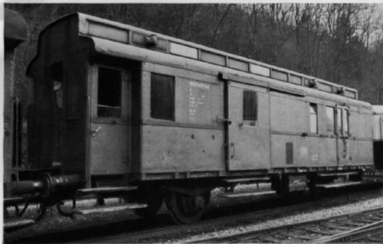
Abb. 8. Ein typischer Nebenbahnwagen ist dieser PwPosti-34. Obgleich er zu den zuletzt gebauten Zweiaxseln der DR gehört, wirkt er mit dem Oberlichtdach, der unterschiedlichen Türenanordnung und seiner ganzen „Unsymmetrie“ doch herrlich „nostalgisch“. (Foto: Deppmeyer)
