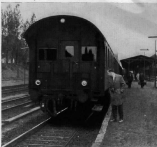
Abb. 10. Ein CI-28 als Wendezug-Steuerwagen BPwif; solche 2-achsigen Steuerwagen waren die Vorläufer der 4-achsigen Eilzug- bzw. Silberling-Steuerwagen; trotz ihres nicht ganz befriedigenden Fahrverhaltens konnten sie sich bis Ende der 50er Jahre im Wendezugbetrieb halten. Die übrigen Wagen solcher Wendezüge waren durchwegs stählerne Einheitswagen, auch der Abteilmotiv (s. Heft 11/72, S. 706). (Foto: H. P. Schulz)
