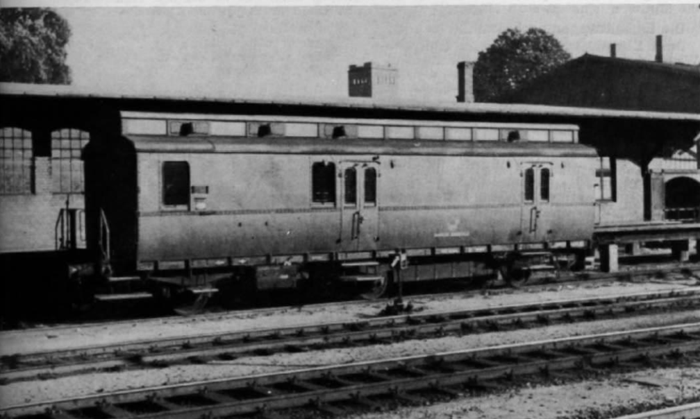
Abb. 7. Auch Postwagen paßten sich dem „Einheitslook“ an, wenngleich man bei ihnen in den zwanziger Jahren auf das Laternendach noch nicht verzichtete. Die Bauzeichnung eines sehr ähnlichen Typs, des Post 3 aus dem Jahre 1925, brachten wir in MIBA 13/64. (Foto: H. P. Schulz)
