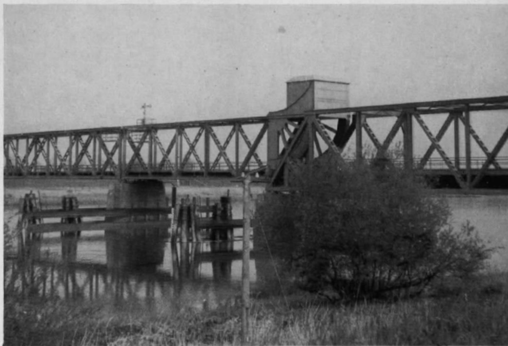
Abb. 3. Die Klappbrücke in geschlossenem Zustand; das — mittlerweile durch Lichtsignale (s. Abb. 1) ersetzte — Schifffahrtssignal (oberhalb des Pfeilers) zeigt „Stop“ an (s. dazu unseren ausführlichen Bericht über Signale an beweglichen Brücken in Heft 12/73).
