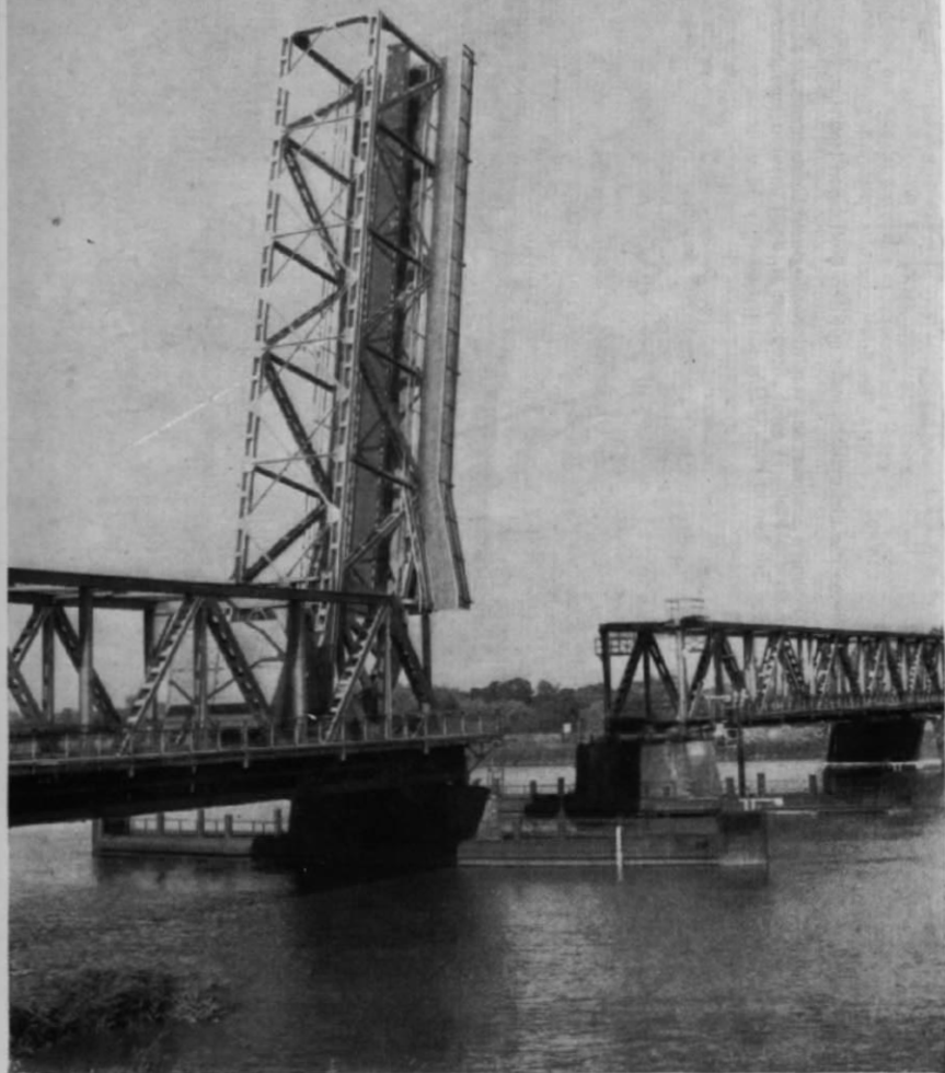
Abb. 1. Die Klappbrücke in geöffnetem Zustand. Das Schiffs-Formsignal der Abb. 3 ist hier schon durch – leider nicht genau zu erkennende – Lichtsignale ersetzt worden.
