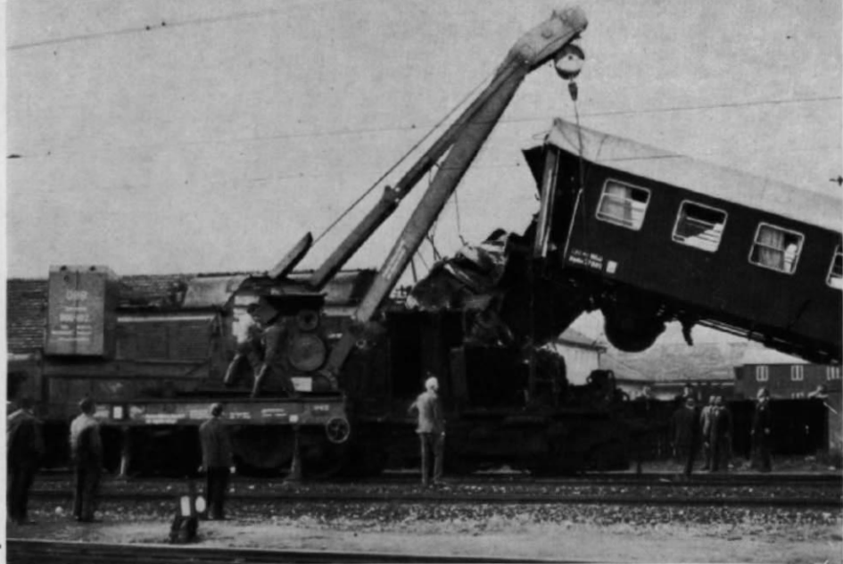
Abb. 1. Der „Hauptakteur“ der heutigen Abhandlung, der dreiachsige Kranwagen, „in action“ nach einem Auffahrunfall: der Kran hebt einen Zweilachser von der Ellok. Der Kran ist hier auf den Schraubstempeln abgestützt, das Gegengewicht ist voll ausgefahren. Die Mannschaft bedient gerade das Drehwerk mittels Handkurbel. Das Hubwerk ist bei den in Österreich verbleibenden Whylen-Kränen nachträglich motorisiert worden.
