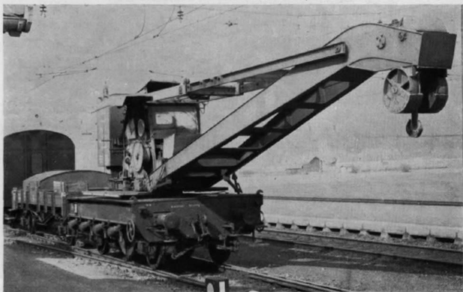
Abb. 8. Der Kranwagen in Transportstellung, aber noch ohne vorgereichten Schutzwagen; unter den Puffern erkennt man die bei Abb. 1 erwähnten Greifzangen. Der Kranausleger besteht aus einer konisch verlaufenden Kastenhohlkonstruktion mit Zwischenquerstegen. Die Auslegerneigung wird dabei durch die jeweils eingestellte Länge der oberen Zugstreben bestimmt, die sich teleskopartig ineinanderschieben und in vier verschiedenen Stellungen mit einem Bolzenmechanismus einrasten können (s. auch Abb. 2).
