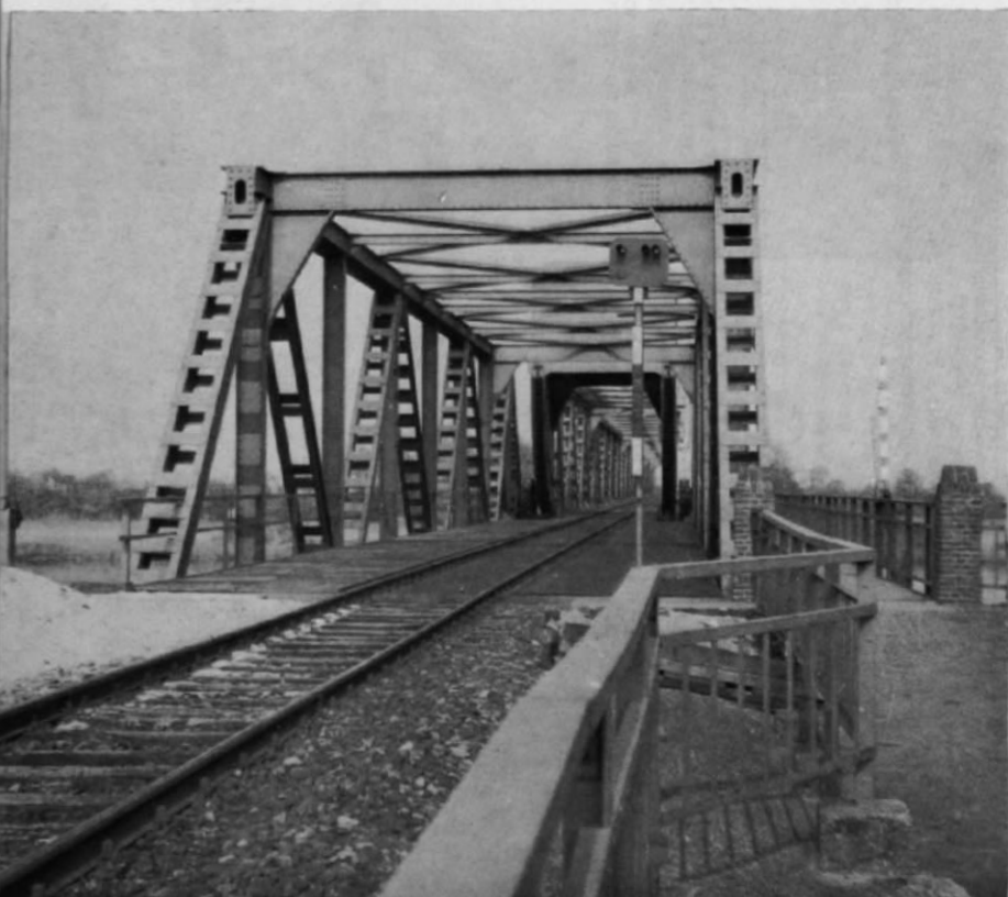
Abb. 7. Blick durch die geschlossene Klappbrücke. Es ist deutlich zu erkennen, daß der erste Oberbau breiter gehalten ist, um das Einschwenken der Klappbrücke zu ermöglichen. Vor der Brücke das im Haupttext erwähnte Deckungssignal.
