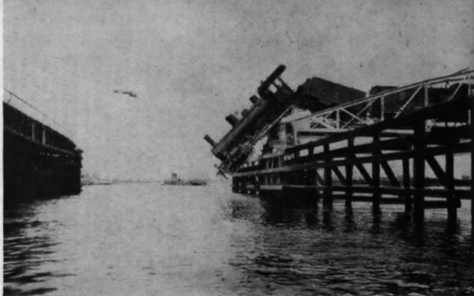
Abb. 6. Ein historisches Fotodokument: dieses Eisenbahnunglück, das zum Glück ohne schwerere Folgen blieb, ereignete sich 1913 auf der Drehbrücke, die bis 1924 an Stelle der heutigen Klappbrücke bei Weener über die Ems führte. Infolge eines Mißverständnisses war der Zug auf die offene Drehbrücke gefahren, konnte aber dank der Geistesgegenwart des Lokpersonals „gerade noch“ abgebremst werden.
