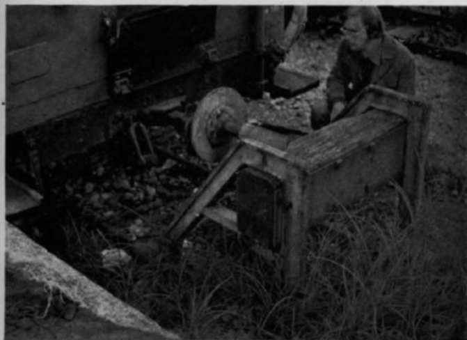
Abb. 1 u. 2. Zwei der Mittelpuffer-Prellböcke, fotografiert im Bf. Mayrhofen der Zillertalbahn.
