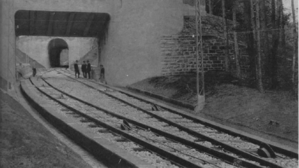
Abb. 5. Diese Abbildung von einer Ausweichstelle der Merkur-Standseilbahn in Baden-Baden zeigt die schräge Anordnung der Seiltragrollen bei einem Kurvenabschnitt. (Foto: Lok Magazin/Archivbild Esslingen)
