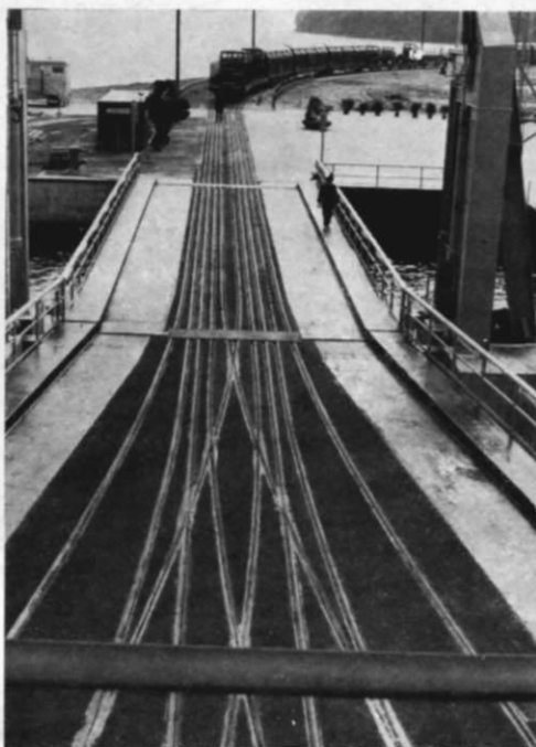
Abb. 10 u. 11. Die Zufahrt zur Fähre erfolgt über ein „verschachteltes“ Spezialgleis, das sich an Bord der Fähre wieder in fünf Stränge teilt.
