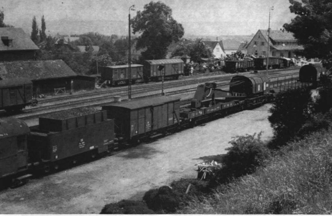
Abb. 1. Ein richtiges „Bauzug-Stimmungsbild“ — als „Appetitanreger“ für die Gestaltung eines ähnlichen Motivs auf der Modellbahn! Hier steht ein Gleisbauzug abgestellt im Bf. Rottenburg/Neckar. Ganz links spitzt ein Wohnwagen hervor; es folgen: zum Wasserwagen umgebauter Dampflok tender (sogar noch mit Kohle), Gerätewagen, Schutzwagen, Kranwagen, Gleisjoch-Wagen und ein weiterer Kranwagen. Gegenüber am Prellbock sind zwei weitere Bauzug-Wagen abgestellt.
