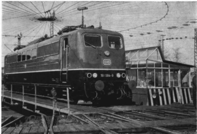
Abb. 1. Die Drehscheibe mit Oberleitungsspinne im Nürnberger Bw nebst dem ungewöhnlichen, jedoch zweckdienlichen Bedienungshaus.
