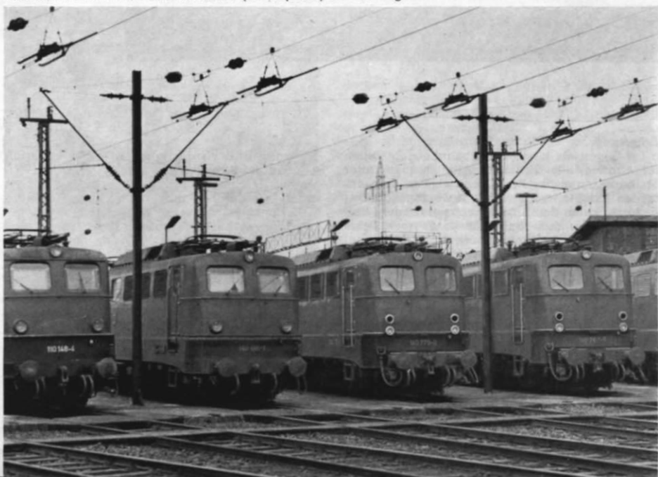
Abb. 9. Diese Aufnahme aus dem Bw Duisburg-Wedau zeigt, wie die Fahrleitungen über den Abstellgleisen hinter der Drehscheibe durch Streckentrenner elektrisch von der „Spinne“ isoliert sind; sie können je nach den betrieblichen Erfordernissen (s. Haupttext) ab- und angeschaltet werden.
