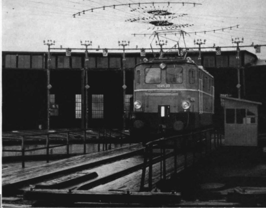
Abb. 11 u. 12. Eine „Doppelspinne“ (mit Tragseilen) aus dem Nachbarland Österreich. Zum Zeitpunkt der Aufnahme waren in diesem Bw noch Dampf-, Diesel- und Elloks beheimatet, weswegen auch hier nicht alle Schuppengleise überspannt sind (links). Im Prinzip entspricht diese „Spinne“ auch den deutschen Konstruktionen, bis vielleicht auf die vor dem Schuppen aufgestellten Abspannmaste.
