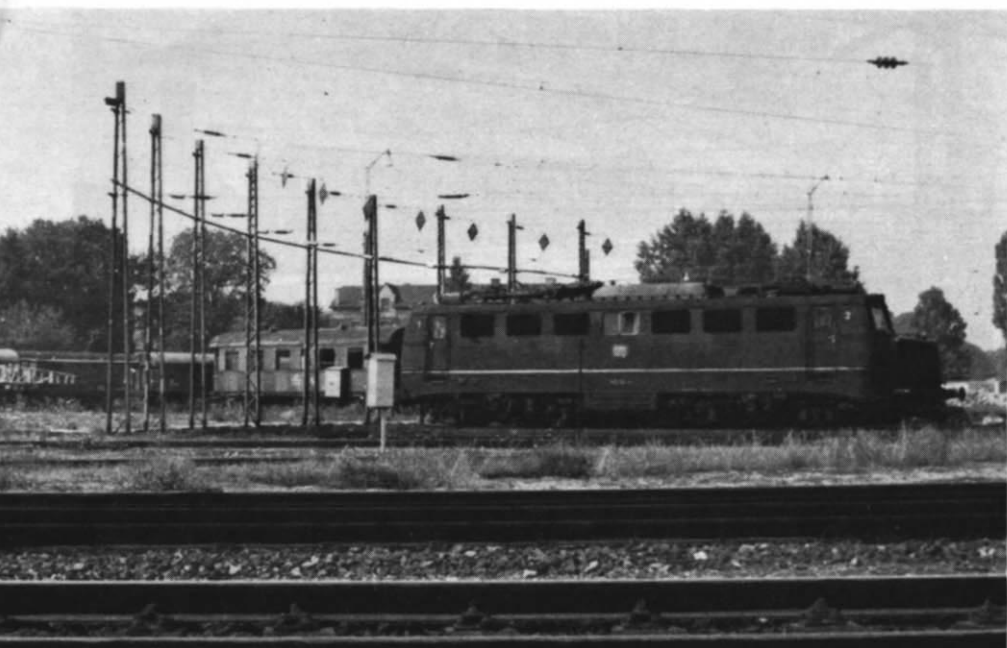
Abb. 6. „Doppelspinne“ und ein Teil der Abspannmaste im Bw Rosenheim mit den zwischen den Masten aufgehängten „El 6“-Signalen (s. Abb. 7).
