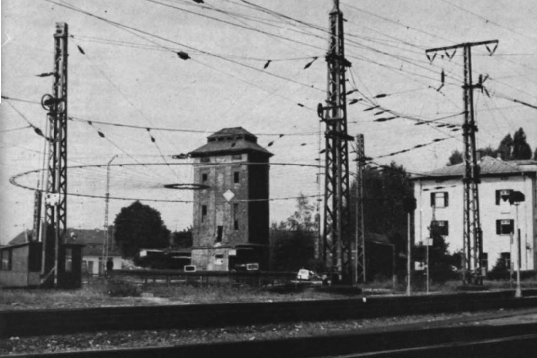
Abb. 8. Eine „Doppelspinne“ im Bw Rosenheim, bei der die Tragseile wegen des relativ langen Abstandes Zentrum/Abspannmaste notwendig sind. (Fotos Abb. 6 u. 8: Hannibal Gude, Boppard/Rhein)
