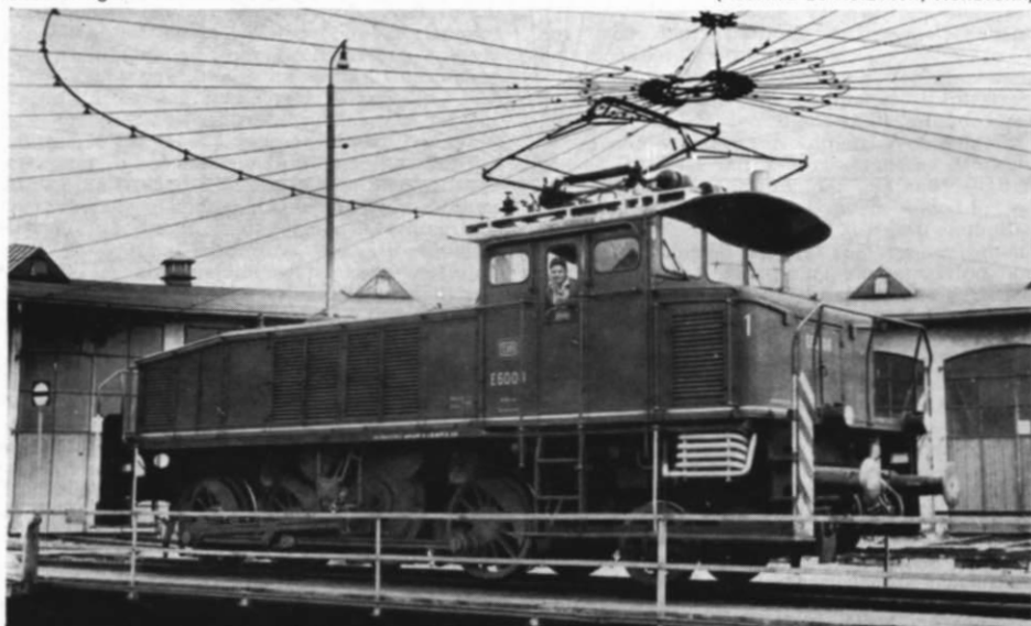
Abb. 3. Eine „Spinne“ im Bw Freilassing, bei der dreierlei gut zu erkennen ist: 1. die Tragkonstruktion, an der der zentrale Ring der „Spinne“ aufgehängt ist, 2. die Verbindungsleitung (sog. E-Verbinder), die in ca. 1 m Abstand vom Zentrum den elektrischen Kontakt zwischen den einzelnen Leitungen herstellt, 3. der zweite, äußere Ring etwa über dem Drehscheibenrand, der einer zusätzlichen Verbindung und Justierung der Fahrdrähte dient. (Foto: K. D. Holzborn, Heilbronn)
