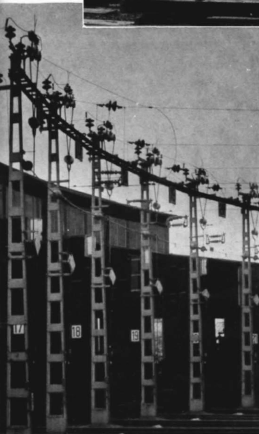
Abb. 11 u. 12. Eine „Doppelspinne“ (mit Tragseilen) aus dem Nachbarland Österreich. Zum Zeitpunkt der Aufnahme waren in diesem Bw noch Dampf-, Diesel- und Elloks beheimatet, weswegen auch hier nicht alle Schuppengleise überspannt sind (links). Im Prinzip entspricht diese „Spinne“ auch den deutschen Konstruktionen, bis vielleicht auf die vor dem Schuppen aufgestellten Abspannmaste.
