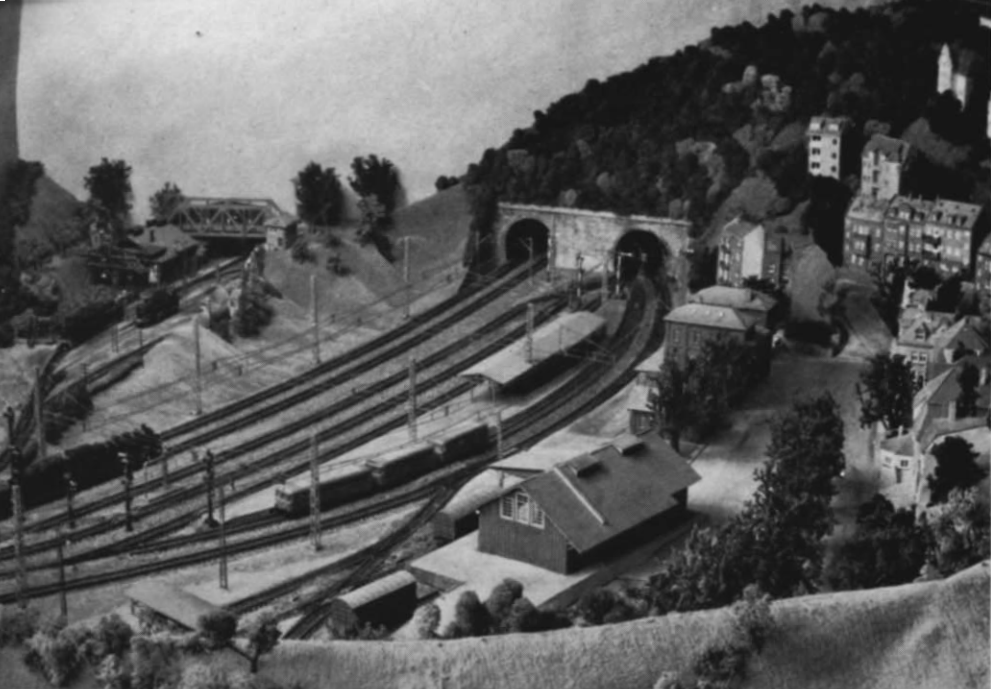
Abb. 3. Überblick über den Vorortbahnhof „Eckstadt-Nord“, der in einer leichten Kurve angelegt ist. Dazu wurden die Märklin-K-Gleise unterseitig aufgesägt und leicht gebogen; dadurch ergeben sich elegante Kurven. Im Hintergrund links liegt die Bw-Zufahrt.
