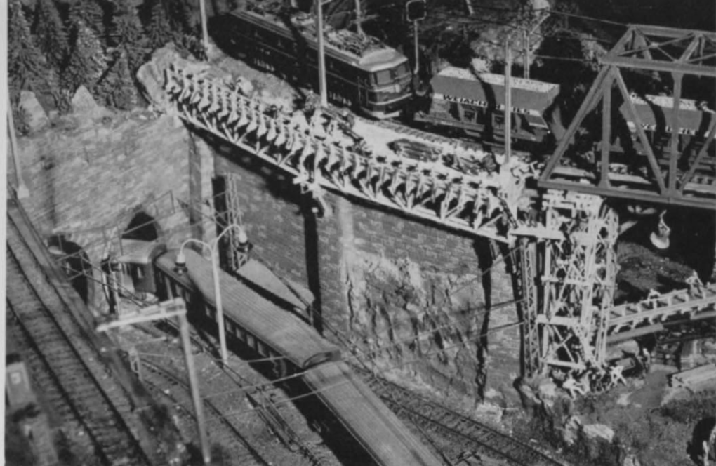
Abb. 9. Nochmals das linke Widerlager der Brückenbaustelle (Abb. 1 und „A“ im Streckenplan). Man sieht die Details der Verbreiterung für die Streckung der Gleisraden zur Erhöhung der zulässigen Geschwindigkeit. Deutlich erkennbar auch hier die Lehrgerüst-Konstruktion und die „Schalungsknaggen“. Die erste Etappe (rechts) ist bereits betoniert. Auf diesem Streckenabschnitt ist bereits die SBB-Oberleitung (Sommerfeldt) montiert.
