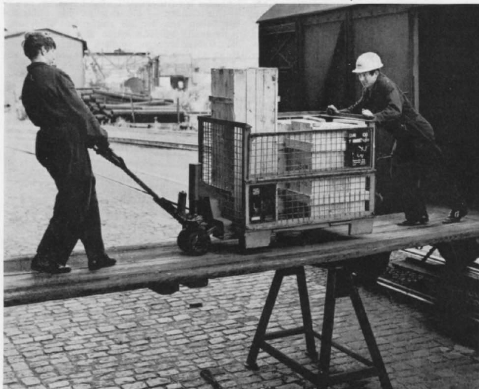
Abb. 12. Verladen von Kisten unterschiedlicher Größe mittels einer Gitterboxpalette.
