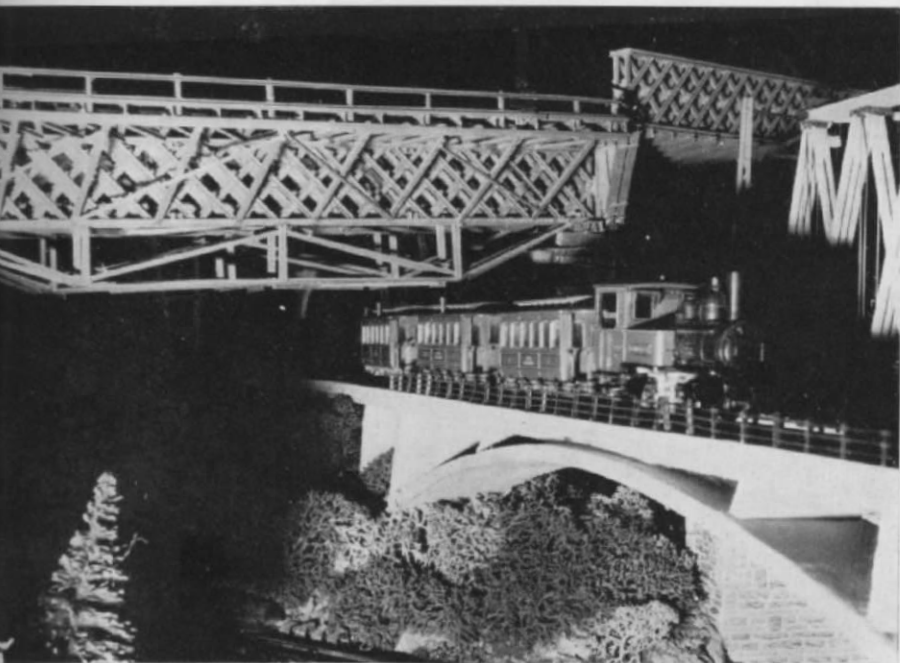
Abb. 4. Diagonalgurtbrücken („E“ im Gleisplan) als Untergurt- bzw. Obergurtbrücke (60 cm lang). Die Untergurtbrücke wurde später wegen der Achslasterhöhung verstärkt. Rechts wieder die Stahlbeton-Bogenbrücke für die Schmalspurbahn („D“ im Gleisplan).
