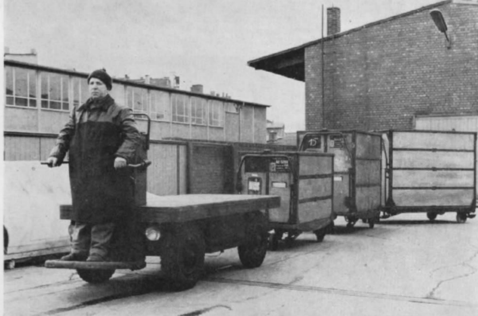
Abb. 1. Ein Elektroschlepper mit den drei verschiedenen Kleincontainer-Typen (mit 1, 2 und 3 m 3 Laderaum). Alle Fotos: DB
