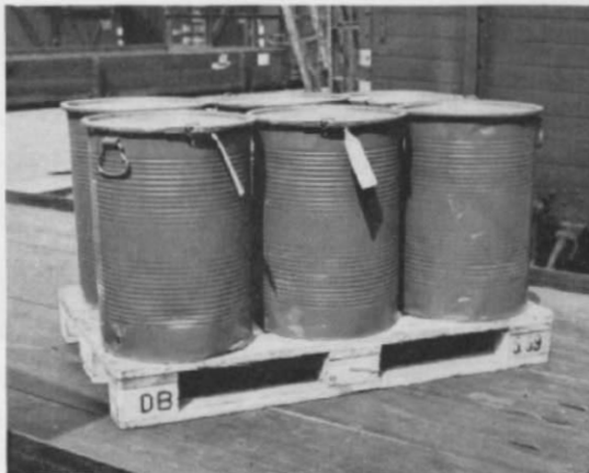
Abb. 9. So werden z. B. Tonnen auf einer Flachpalette rationell verladen.
