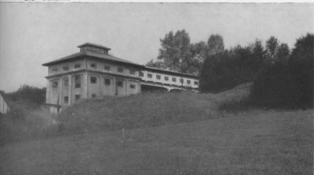
Abb. 3. Eine weitere, heute noch in Betrieb befindliche Brecheranlage. Aus dem Vorbau links ging früher die Seilschwebeseilbahn zur Aufbereitungsanlage im Tal, die heute durch ein Förderband — ganz links im Bild — ersetzt ist.
