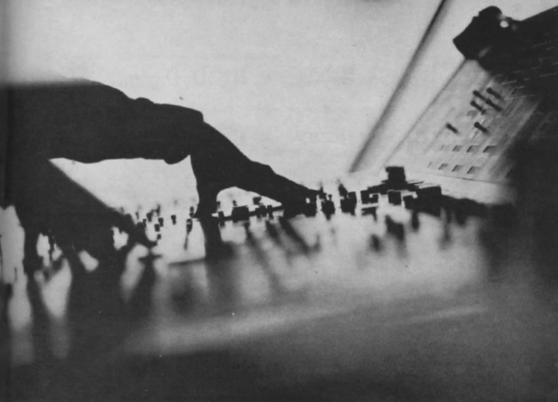
Eine moderne Foto-Graphik vom modernen Eisenbahnbetrieb: Auf einem Gleisbildstellpult wird eine Fahrstraße eingestellt. Man erkennt, daß der Beamte – wie bereits mehrfach in dieser Artikelserie erläutert – mindestens zwei Drucktasten gleichzeitig betätigen muß, wodurch versehentliche Fehlschaltungen ausgeschlossen werden. (Foto: Siemens)
