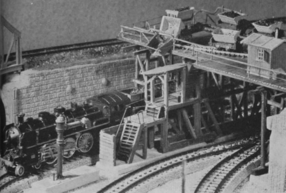
Abb. 2. Gerade wird eine Lore an der sog. „Kohlenbrause“ entleert, durch die die Kohlen in den Loktender „poltern“.
