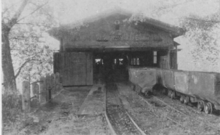
Abb. 4. Blick in die Brecheranlage der Abb. 3. In der Mitte rollen Loren über eine Waage zur Entladung, rechts rollen die Leerwagen zurück.
