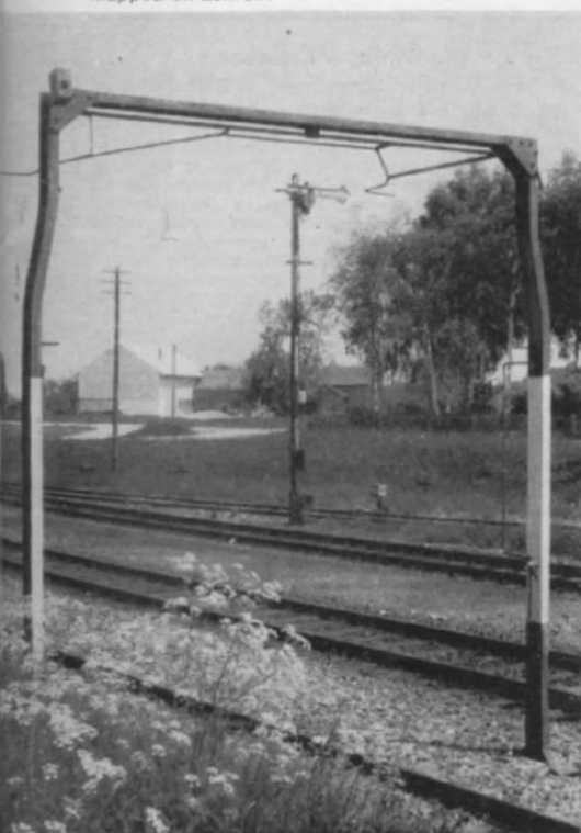
Abb. 10 u. 11. Foto und H0-Skizze eines DB-Lademaßes in Bayern, mit Kröpfung und nach oben klappbaren Lehren!
