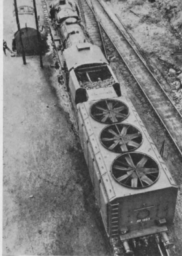
Abb. 1 u. 2. Vorbild und Modell: links ein Blick auf den Tender einer Kondens-52 (Foto: Rheinstahl AG Transporttechnik), oben das H0-Modell aus der DDR. Zur Nachbildung der typischen Lüfterräder drückt man die runden Einsätze im Tendergehäuse heraus, sägt die „Propeller“ aus 0,3 mm-Alublech o. ä. und verwindet sie ganz leicht. Dann wird entweder der Kunststoff-Ring der alten Lüfter ausgesägt oder ein neuer Ms-Ring im passenden Durchmesser angefertigt. Das feine Drahtgitter (evtl. nach MIBA 9/73 aus alten Radioröhren) wird mit Cyanolit eingeklebt, gleichfalls die Verstreibungen, die man aus 0,3 mm-Stahldraht zusammenbaut. Unter den Lüfterrädern ist das Bleigewicht schwarz zu streichen; die Öffnung unter dem mittleren Rad deckt man mit einem dünnen schwarzen Blech ab. Zum Abschluß kann man die Lüfter noch „betriebsgerecht“ verschmutzen.
