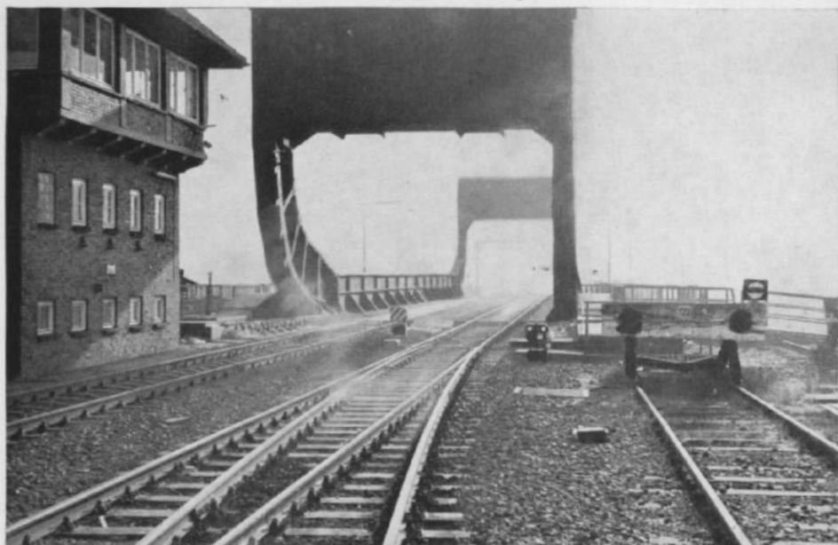
Abb. 1. Die heutige Situation bei der Oldenburger Klappbrücke (Blick von der Bahnhofseite aus). Links das Stellwerk „Brücke“ ohne die mittlerweile abgebaute Signalbrücke. Ungefähr in Bildmitte: eines der heutigen Brückendeckungs-Gleissperrsignale (rechts) und ein Rangier-Gleissperrsignal. (Fotos J. Braun)
