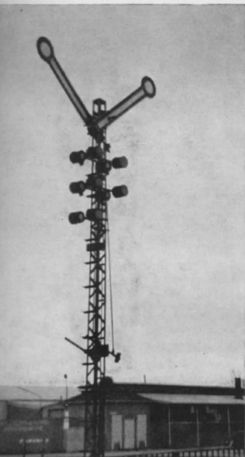
Abb. 8 u. 9. Das besagte Doppelflügel-Schiffahrtssignal an der Emdener Klappbrücke über den Rats- delft sowie eine zeichnerische Rekonstruktion in \frac{1}{4} H 0 -Größe. Da die fünf Signallampen keine beweg- lichen Blenden haben, wird ein Nachbau sehr er- leichtert: die Masthöhe ist nicht verbindlich, son- dern auf die örtlichen Verhältnisse abzustimmen. (Foto: H. Walter, Westrauderfehn)
