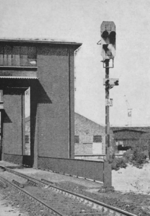
Abb. 5. Das moderne Gegenstück zum Form-Schutzhalt-Signal: ein Lichtsignal zur Deckung beweglicher Brücken, das aus einem umgebauten Haupt/Sperr-Signal entstand. Gut zu erkennen sind die beiden Blechflicken, mit denen die grüne bzw. gelbe Lampe abgedeckt sind. Unter dem Hauptschild sitzt am Mast das Not-Rot-Signal (vgl. Haupttext).
