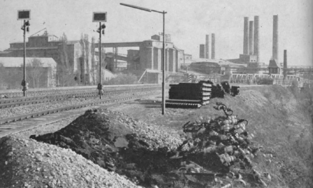
Abb. 1. Durch diese Schutzhalt-Signale wird die im Hintergrund erkennbare Drehbrücke über die Stör gedeckt. Fotos Abb. 1—3: H. Wiener, Brunsbüttelkoog
