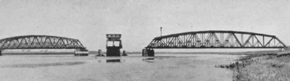
Abb. 2. Eine Drehbrücke über die Eider-Mündung bei Friedrichstadt in geöffnetem Zustand. Drehbrücken findet man beim Überbrücken breiterer Gewässer, bei denen ein Drehpfeiler in Gewässermitte den Schiffsverkehr nicht stört und der Bau dieses Pfeilers technisch/betrieblich möglich ist.
