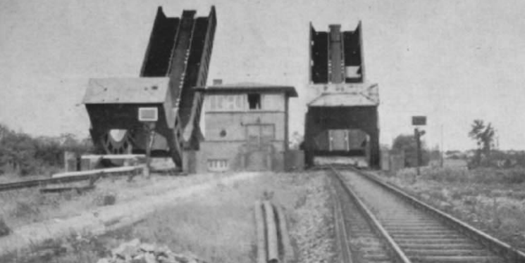
Abb. 9. Die Klappbrücken der Abb. 6 in angehobenem Zustand, von der Bahn aus gesehen. Deutlich sind auch hier die zungenartig ausgebildeten Schienenenden (vgl. Abb. 8) zu erkennen. Auch das hier zweifach vorhandene bewegliche Schutz-Halt-Signal zur Brückendeckung werden wir noch gesondert behandeln.
