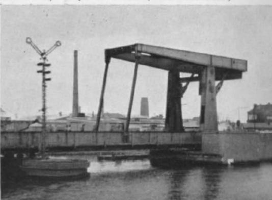
Abb. 10. Eine Klappbrücke mit hochliegendem Träger und Ausgleichs-Hebelwerk (eine weitere Variante und Gegenstück zur Scherzer-Bauart) über den Ratsdelft in Emden. Besonders interessant erscheint hier das die Schifffahrt sichernde Doppel-flügel-Signal (nähere Beschreibung und BZ folgen demnächst). (Foto: H. Walter, Westrahauderfehn)
