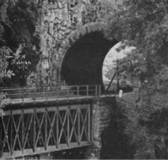
Abb. 19 u. 20. Eine Brücke mit anschließendem Bergdurchstich als kurzer Tunnel im Donautal kurz vor Beuron. Uns kommt es jedoch weniger auf die romantische Gesamtsituation an als auf die Ausnahme von der Regel: eine durch den Tunnel weitergeführte Freileitung, wie die nebenstehende Ausschnittsvergrößerung beweist! Vermutlich hat sich für diesen kurzen und daher kaum korrosionsgefährdeten Tunnelabschnitt die Aufstellung zweier Endmasten samt Verkabelung nicht gelohnt.
