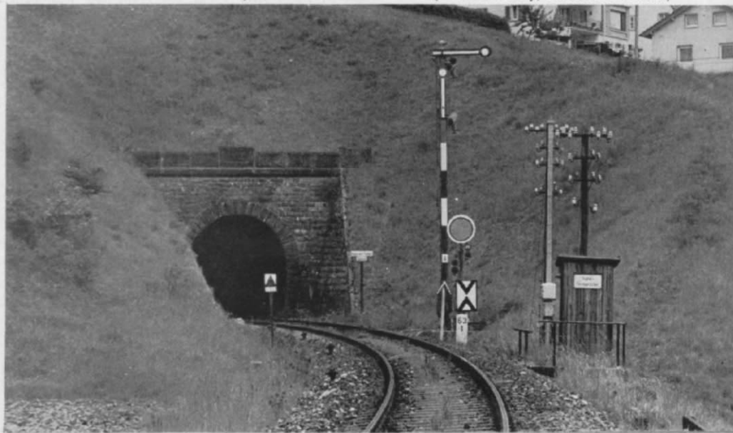
Abb. 18. Ein weiterer Endmast vor einem Tunnel, in dem die Freileitung als Erdkabel weiter läuft. Soweit wir es von hier recherchieren konnten, hat der rechte der beiden Endmasten keine Funktion mehr und wird gerade gegen den neuen (links) ausgewechselt — wofür auch die neue Aluguß-Ausführung des Endverschluß-Kastens beim linken Mast sprechen dürfte.
